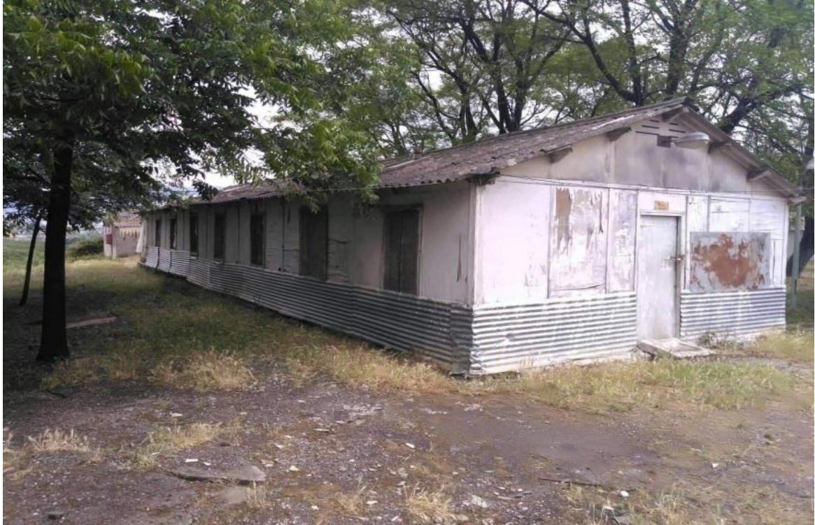
Figure 2 : vue extérieure du bâtiment d'élevage des poulets où s'est déroulé l'essai.
