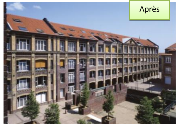
Fig. 7: exemple d'une façade d'un immeuble à Nantes
