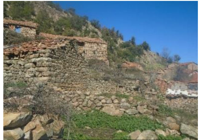
Figure 43 : Le bâti (Voumensour)
