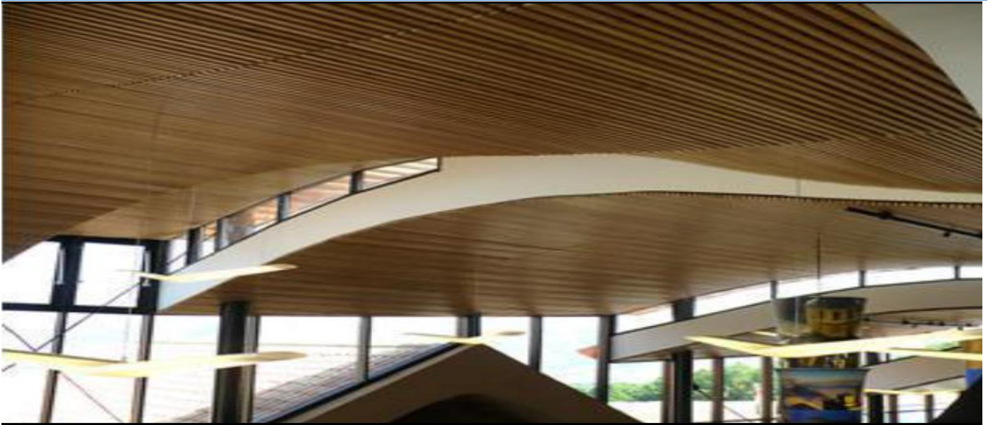
Figure(170): Faux plafond en bois
