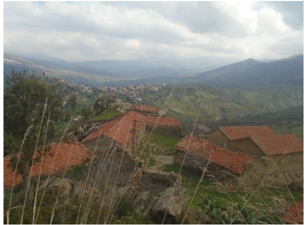
Fig. 36 : Vue sur les toitures Source : Cliché Auteurs
