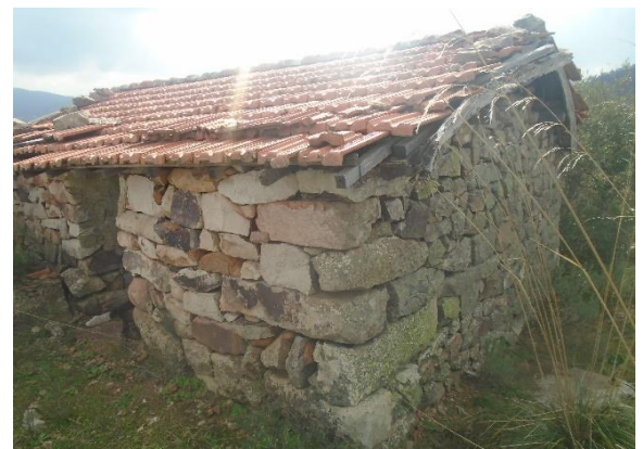
Figure 48 : le bâti (Voumensour) Source : Cliché auteurs
