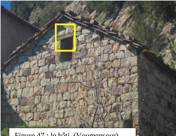
Figure 47 : le bâti (Voumensour) Source : Cliché auteurs
