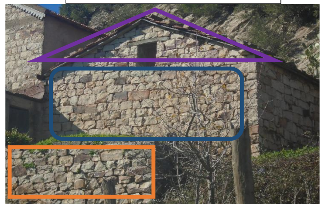
Figure 44 : Le bâti (Voumensour)
