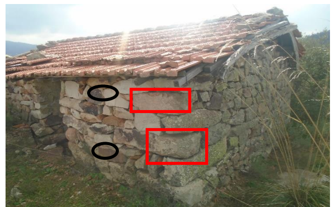
Figure 45 : Le bâti (Voumensour)
