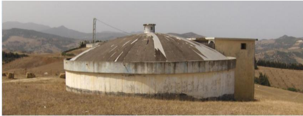
Figure 4.3 : Réservoir semi enterré. Source (HAMMOUM 2012)
