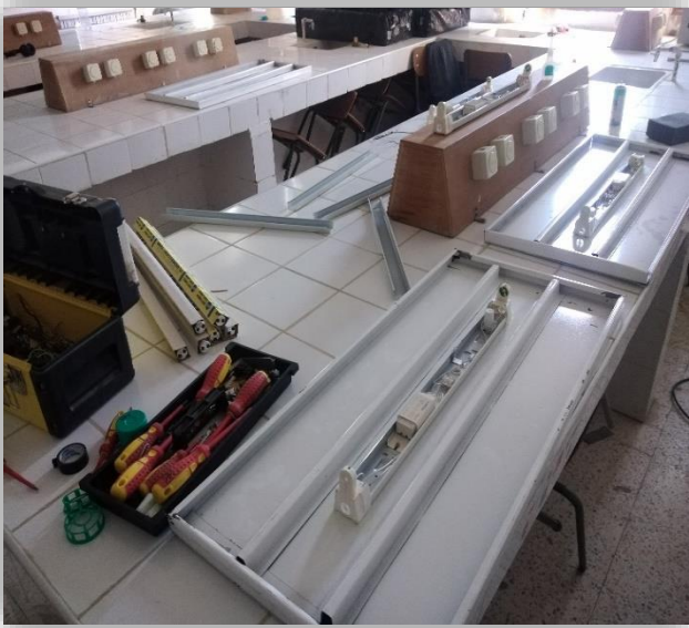
Figure 50. Mise en place de système
