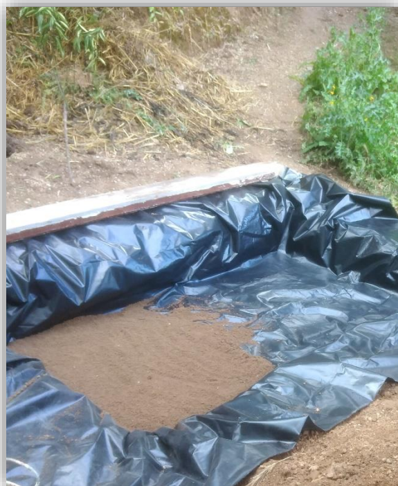
Figure 39 . Bâche posée sur la fosse.
