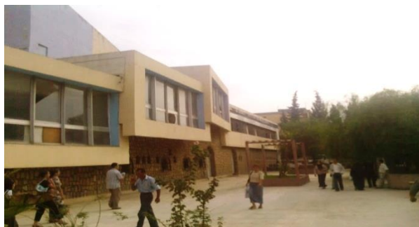
Figure II.18 : façade principale (donnant sur le Boulevard Ben M'hidi) 2004. Source : bureau d'études KERRICHE
