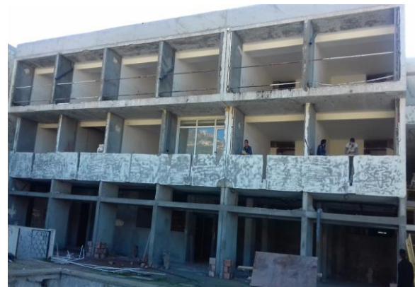
Figure III.33 : façade principale de l'hôtel en cours de réhabilitation Source : auteurs
