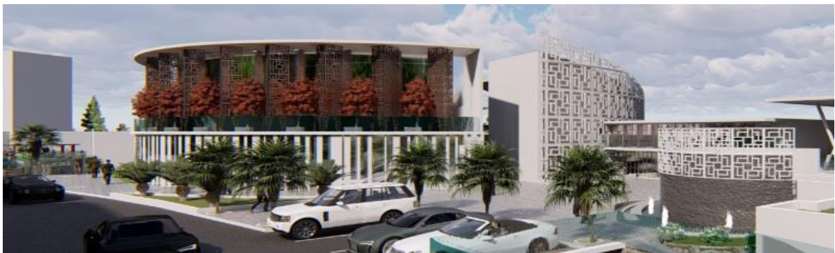
Les deux dispositifs et la couverture de la façade vue donnant sur l'accès principal
