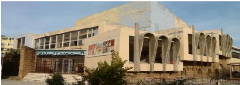
Figurell.21 : image montrant la mise en œuvre des arcs en béton 2007 Source : collection personnelle
