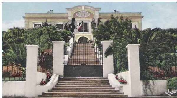
Figure I.10 : Façade sous -préfecture Source : Google
