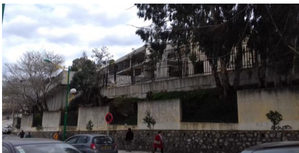
Figure III.35 : Mur de soutènement (voie frères Bouzidi). Source : auteurs
