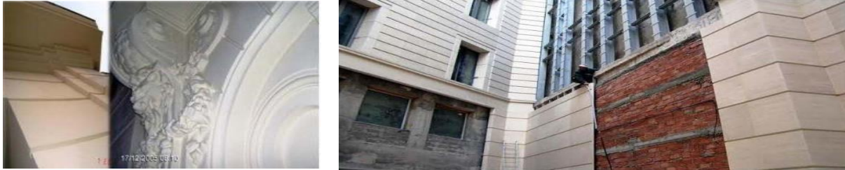
Figure 07 : A gauche : Reprise des enduits et des fresques à l'identique. A droite : Scellement de la pierre sur le mur de patio.
