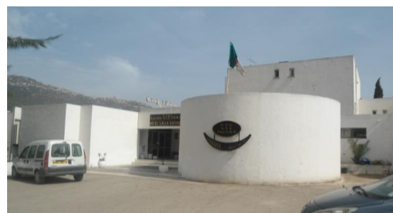
Figure III.36 : Entrée principale en chicane. Source : bureau d'études SAZA.
