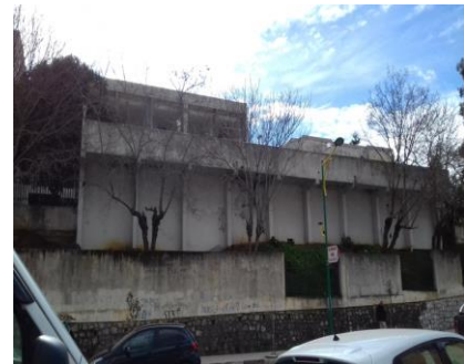
Figure III.40 : Porte-à-faux de la terrasse. Source : auteurs.
