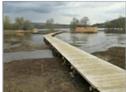
Figure 15:Aménagement d'une passerelle source: parc naturel régional des volcans d'Auvergne.
