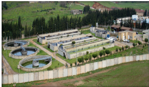
Figure 7 : vue générale de la STEP de Boumerdès (ONA, Boumerdès, 2016).
