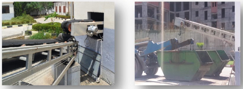
Figure 18: boues déshydratées (ONA. Boumerdès, 2016)
