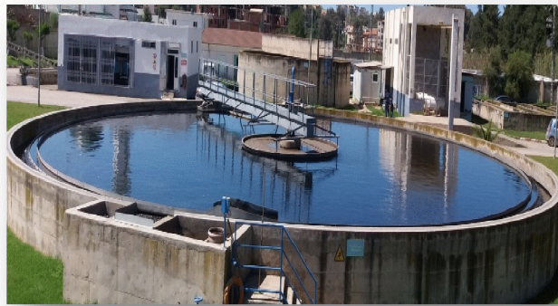
Figure 13 : Bassin de clarification (ONA. Boumerdès, 2016)
