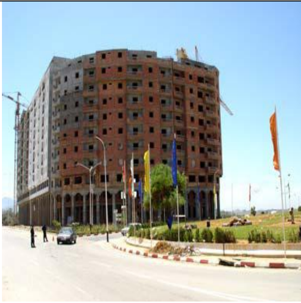
Fig.I.10 : Bâtiment en cours de construction dont la sauvegarde est due à la présence des cages d'ascenseur en voile en béton armé (Fig.I.11 et I.12)
