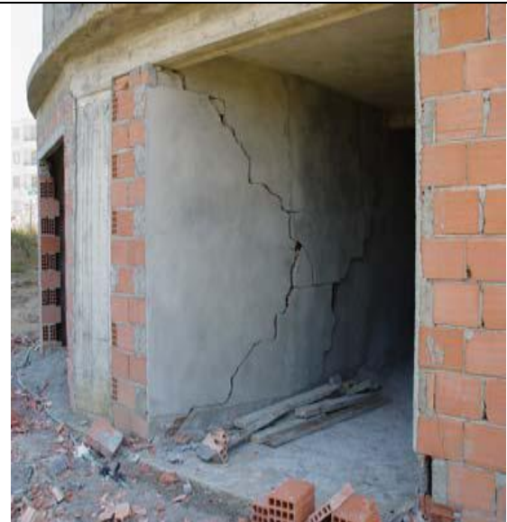
Fig.I.13 : Bâtiment en cours de construction dont la sauvegarde est due à la présence des cages d'ascenseur en voile en béton armé
