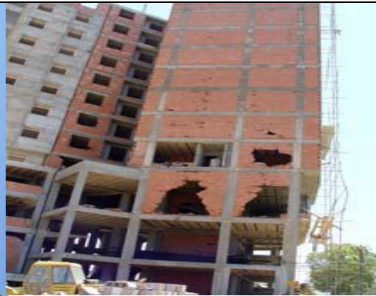
Fig.I.9 : Bâtiment en cours de construction dont la sauvegarde est due à la présence des cages d'ascenseur en voile en béton armé
