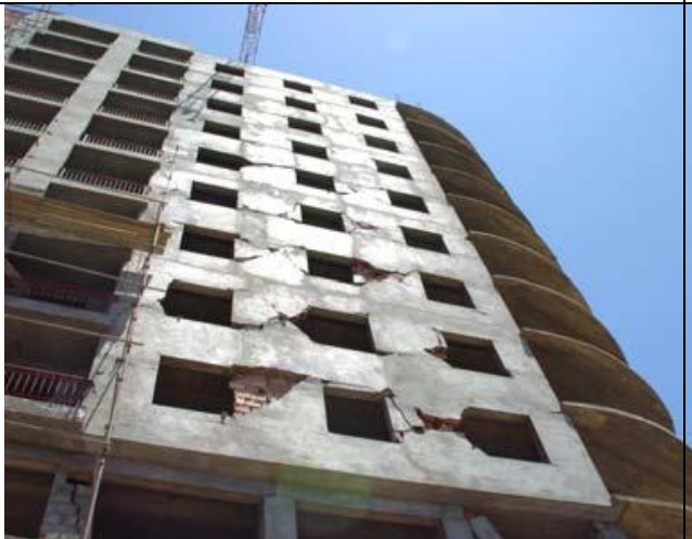
Fig.I.8 : Bâtiment en cours de construction dont la sauvegarde est due à la présence des cages d'ascenseur en voile en béton armé
