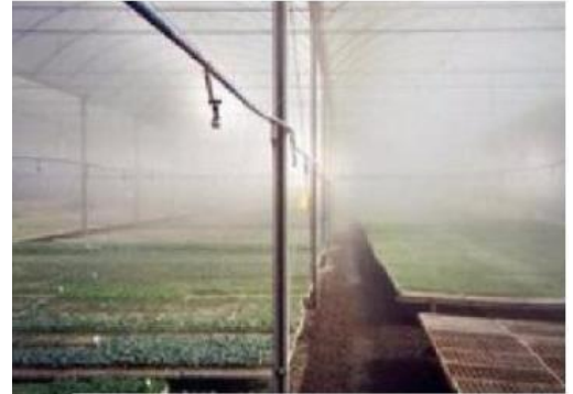
Figure 334 : un Système de brumisation Source : mémoire 2015-2016. Ferme urbaine à Oran
