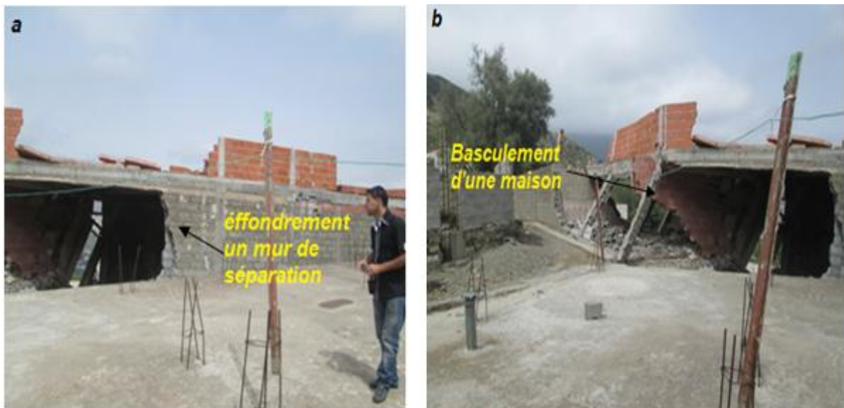
Figure 3.22 : Vues des dégâts au site étudié village Ouled Ali commune Teskriout.
