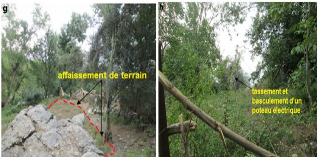
Figure 3.27 : Vues des dégâts au site étudié village Echetal commune Ait Smail (suite).
