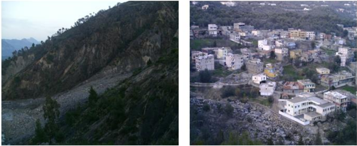
Figure 3.5 : Village Echetel menacée par le glissement de terrain (AGC, 2012).
