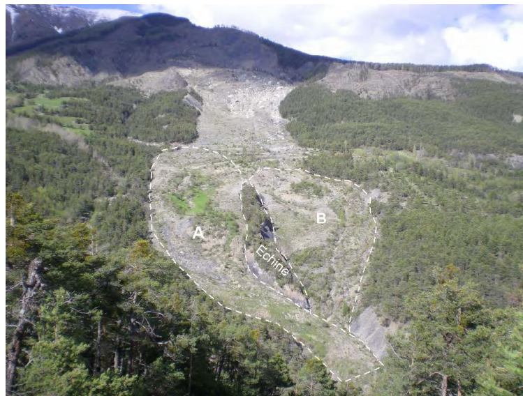
Figure 1.9 : Localisation et photo de la zone de glissement, avec positionnement des profils.
