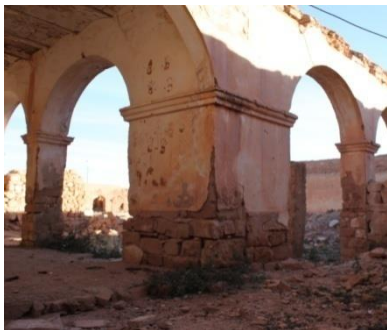
Figure IV-58 : Photos montrant un détail du chevauchement de deux arcades. Source : Auteur
