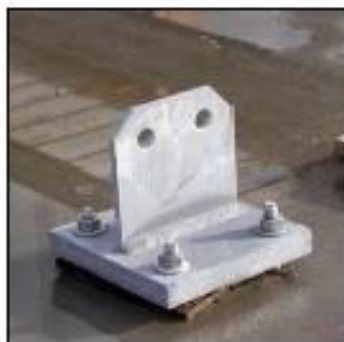
Figure IV-84: : Pieds de poteaux en acier galvanisé
