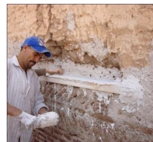
Figure IV-78 Le rejointoiment des façades
