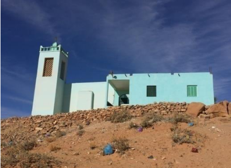
Figure IV-7 : Photo du marabout. Source : Auteur
