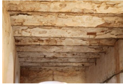
Figure IV-61 : photo d'un détail constructif de la toiture. Source : Auteur
