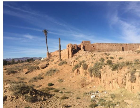
FigureIV-34: Photos prise du côté Sud-est du Caravansérail. Source : Auteur
