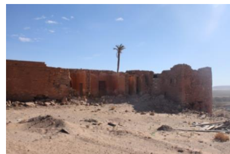
Figure IV-69 : Photo montrant l'état de la façade. Source : Auteur
