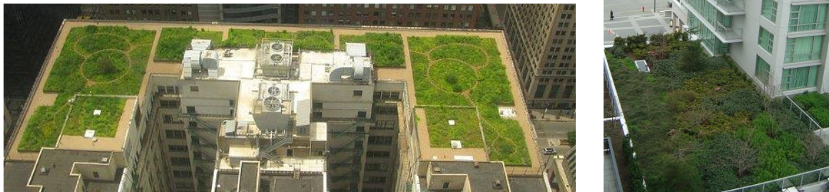
Figure II-4 : Type de couverture en Terrasse Jardin, Source :
