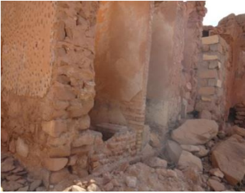
Figure IV-60: Photo montrant un détail d'un mur porteur en pierre. Source : Auteur
