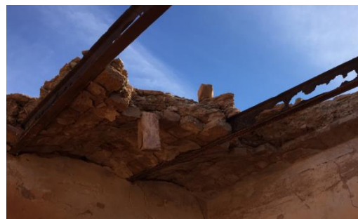
Figure IV-59 : Photos montrant un détail sur une toiture en voutain. Source : Auteur
