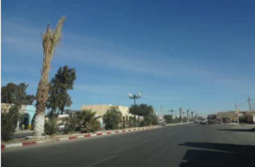
Figure IV-9 : Photo montrant la nouvelle route nationale. Source : Auteur
