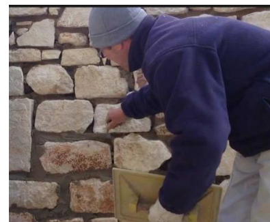
Figure IV-77 Le rejointoiment des façades
