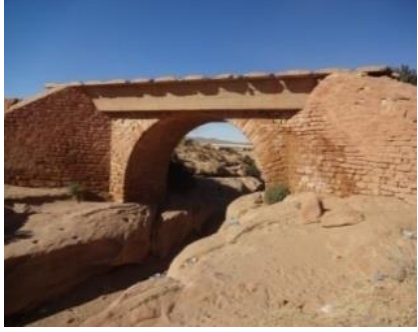
Figure IV-8 : Photo de l’ancienne route nationale. Source : Auteur
