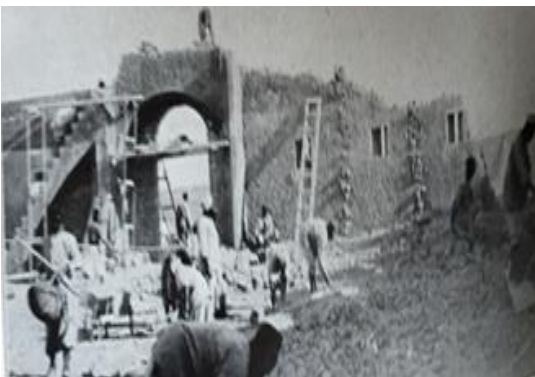
Figure I-9 : Construction de la façade sud de Fort Lallemand Pose de pierre T.1893 de. Coll. Dubuisson. Source : Livre Forts et Bordjs de l'extrême Sud. Page : 49.
