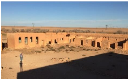
Figure IV-44 : photos du Caravansérail d'Ain el Ibel. Source : Auteur
