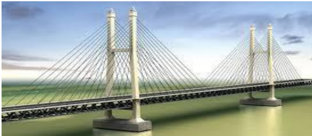
Figure I.7. Pont à haubans
