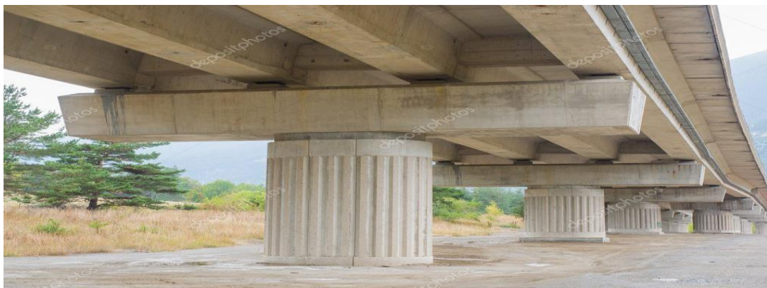
Figure I.4. Pont à poutre en béton armé
