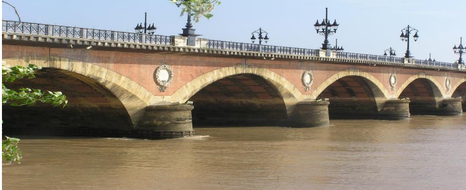
Figure I.3. Pont en maçonnerie
