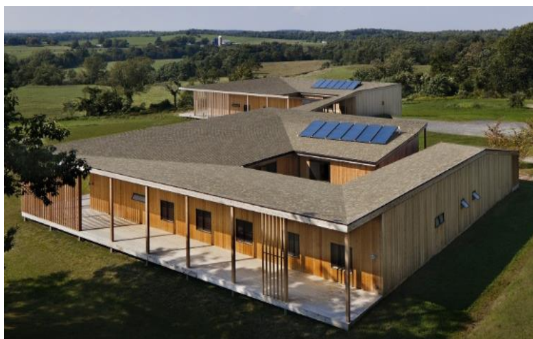
Figure 27 : Panneaux photovoltaïques sur le toit. Source : Architizer, 2018.
