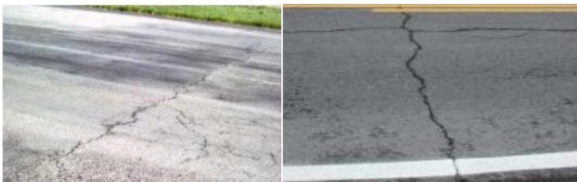
Figure I.12 : fissures transversales.
