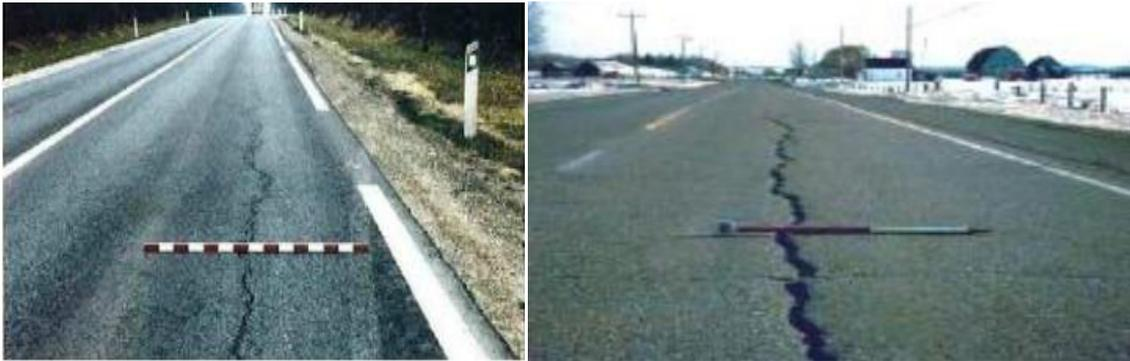
Figure I.11 : Fissures longitudinales.
