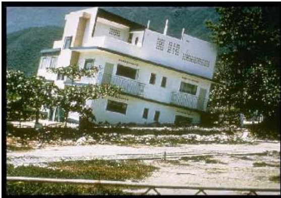
Liquéfaction des sols suite au séisme de Caracas (Venezuela) en 1967.
