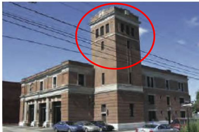
Figure 1. 11 : la tour carrée de Griffintown construite en 1913 et 1914, (Gilles, 2009)
