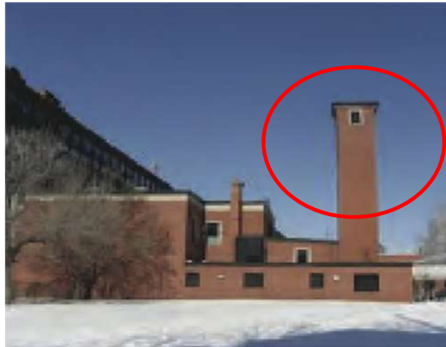
Figure 1. 13 : tours carrée de Sud-Ouest de Montréal construites depuis 1870. (Gilles, 2009)
