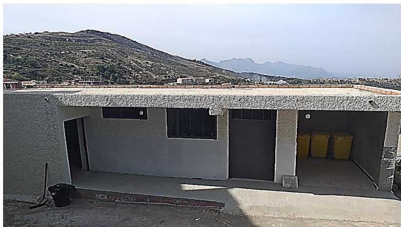
Figure 10 : lieu de stockage des déchets infectieux (juillet, 2020)
