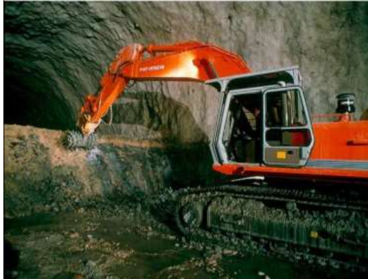
Figure III.2 .Creusement en demi-section (CETU., 1998)
