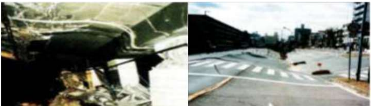
Figure II.1. Effondrement de la route nationale au-dessus de station de métro de Daikai.
