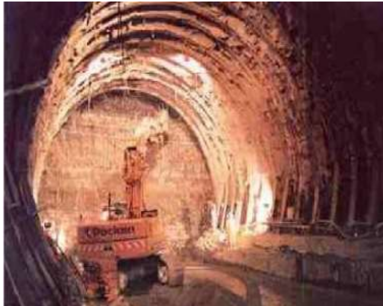
Figure III.1. Creusement à pleine section (CETU., 1998)
