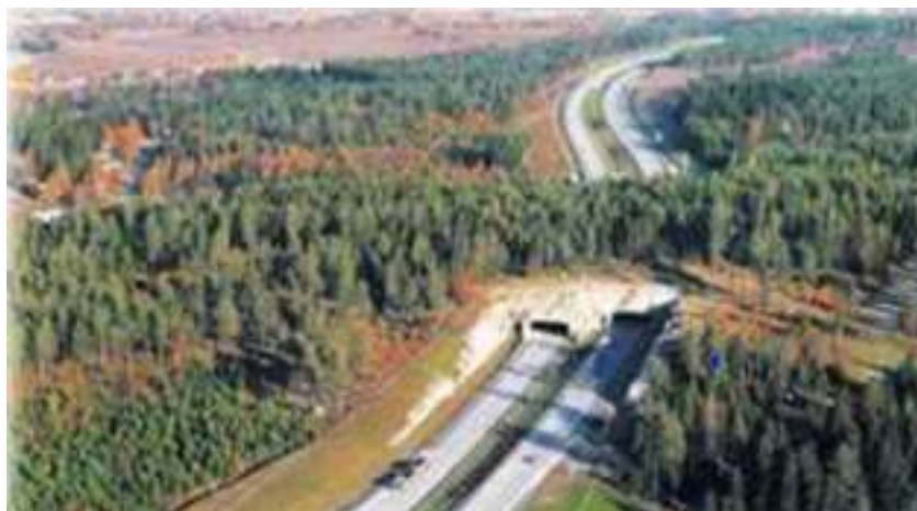
Figure I.3. Tunnel d'autoroute formant une traversée verte permettant le passage des animaux, des personnes et des végétations en Finlande (Godard., 2002)
