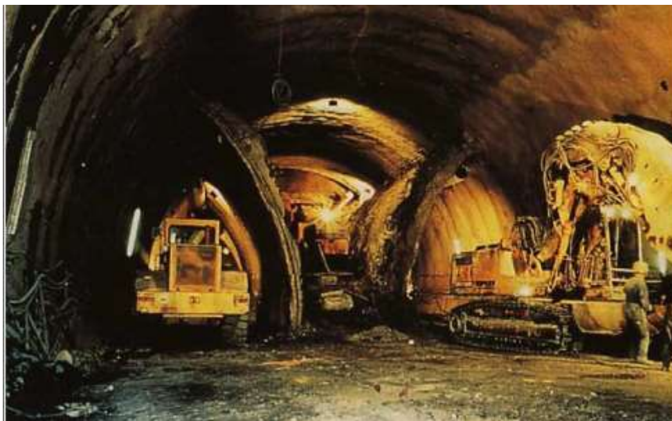
Figure III.3. Creusement en section divisée (CETU., 1998)
