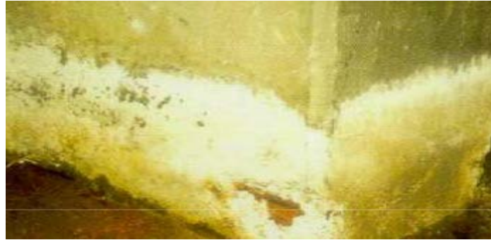
Figure II.11 : Attaques sulfatique externe.
