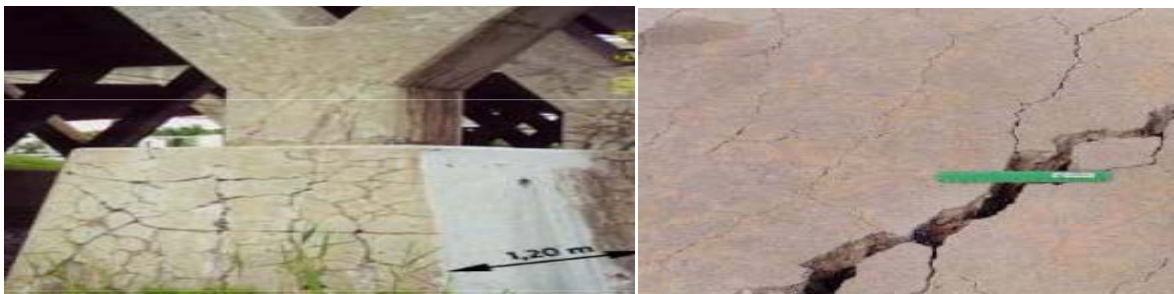
Figure II.5: Phénomène d'alcali réaction rencontré [19].
