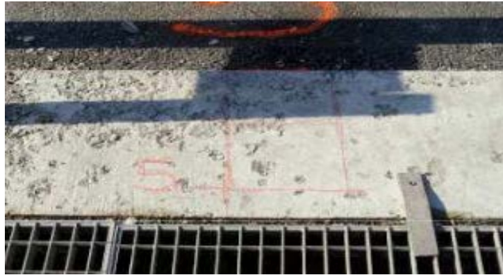
Figure II.7 : Écaillage.
