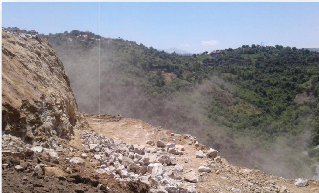
Figure 30. Photo montrant l'émission de poussières pendant la réalisation des travaux d'exploitation
