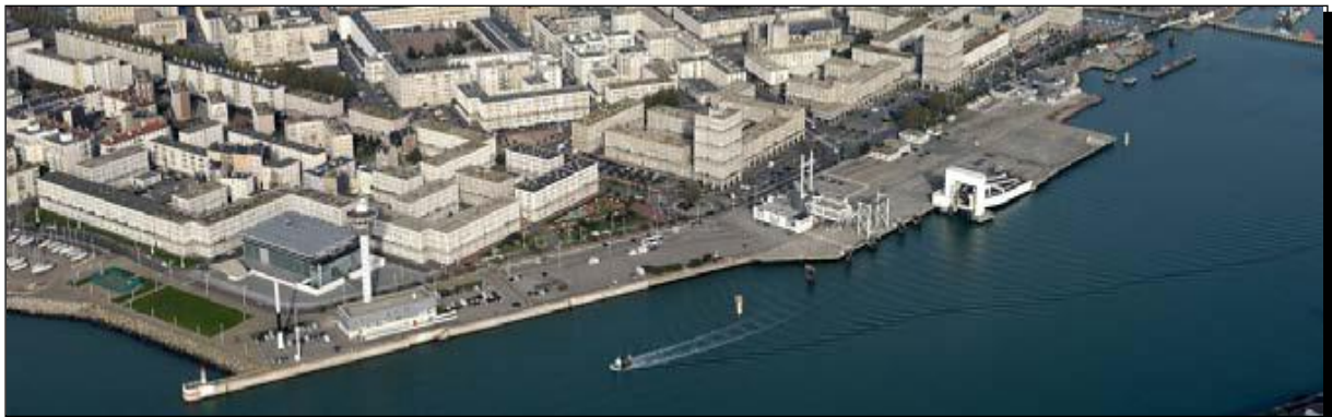
Figure n°9 : Vue vers la chaussée Kennedy et le quai Southampton
