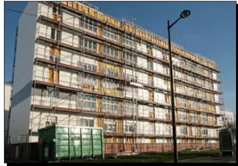
Figure n°20: Réhabilitation d'un immeuble
