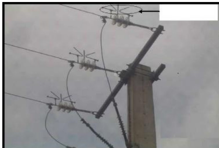
Fig. II.9. Eclateur MT avec une tige anti oiseau.
