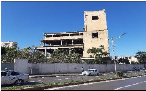
Figure 30 : Photo d'une usine abandonnée Source : Auteurs
