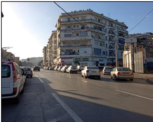
Figure 37 : Maison KIA Motors, style contemporain Source : Auteurs
