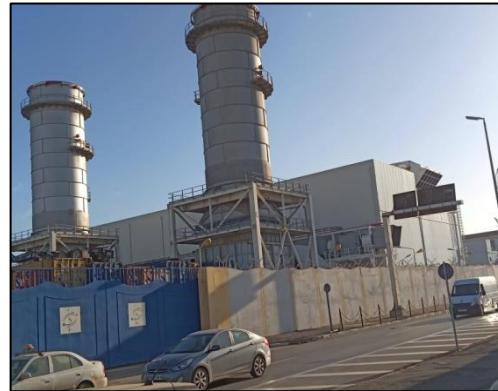
Figure 35 : Construction industrielle Source : Auteurs
