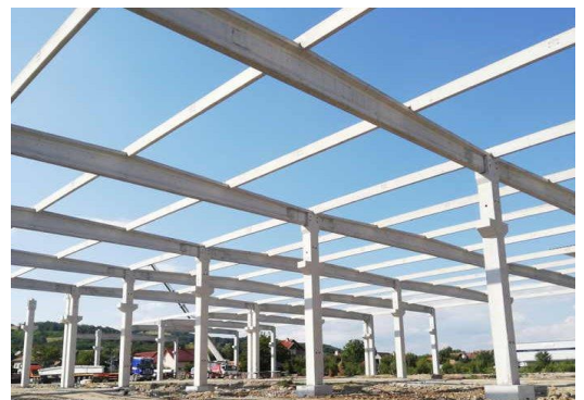
Figure 104: La structure métallique
