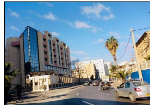
Figure 33 : Immeuble administratif R+5 Source : Auteurs
