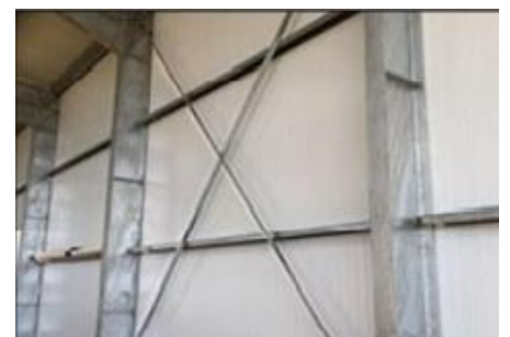
Figure 114: Contreventement par l'intérieur
