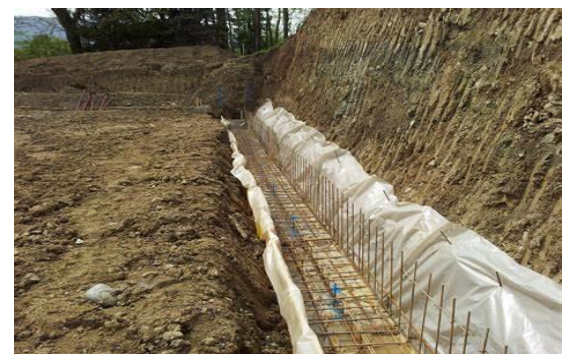
Figure 107: : Mur de soutènement
