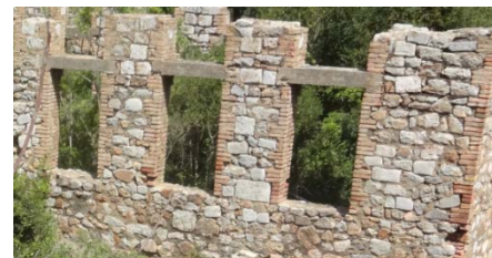
Figure IV-39 : ouvertures du pénitencier Source : auteur
