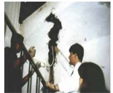
Figure IV- : Réparation des fissures par
