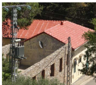
Figure IV-54: Image montrant la charpente du bloc réhabilité. Source : Auteur
