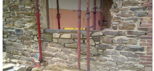
Figure IV- : La réfection partielle des murs affectés au lieu de le reconstruire.
