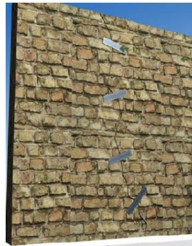
Figure IV- : Remplacement des parties lézardées par des agrafes métallique.
