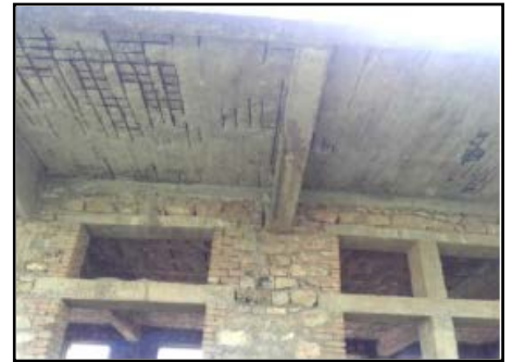
Figure IV-50: Vue sur la couverture Source : auteur
