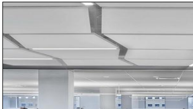
Figure 178: panneaux acoustiques en fibre de verre, source Google image
