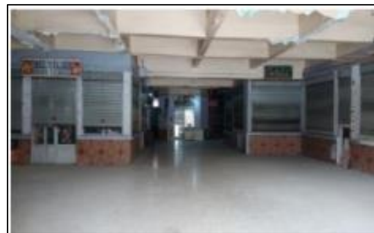
Figure 53: photo du système constructif du bâtiment de l'ancienne gare, source : auteurs
