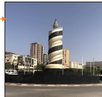
Figure 34: photo de l'intersection de la bougie, source: auteurs
