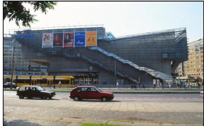
Figure 43: Façade nord du UFA cinéma centre/ Source : wikipiaarquitectura.com
