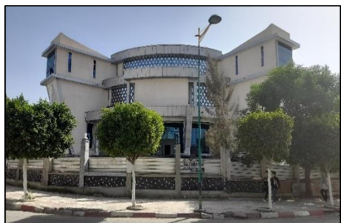
Figure 121: photo de la maison de l'environnement et le musée avant l'intervention, source : auteurs
