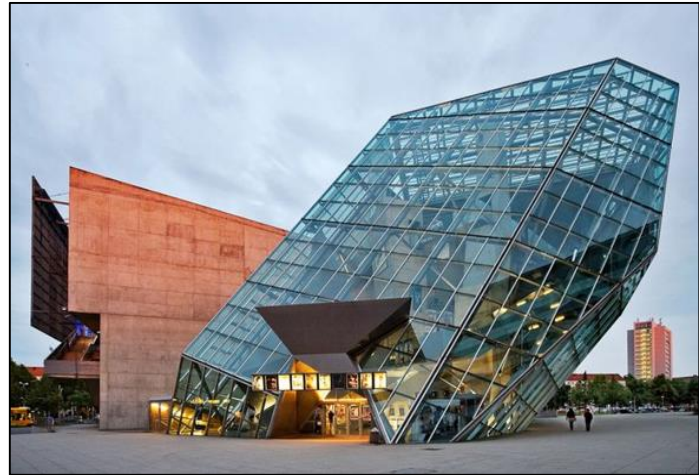
Figure 42: façade sud du UFA cinéma centre/ Source : wikipiaarquitectura.com
