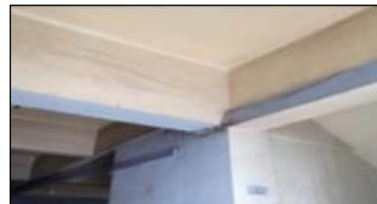
Figure 54: photo du système constructif du bâtiment de l'ancienne gare, source : auteurs
