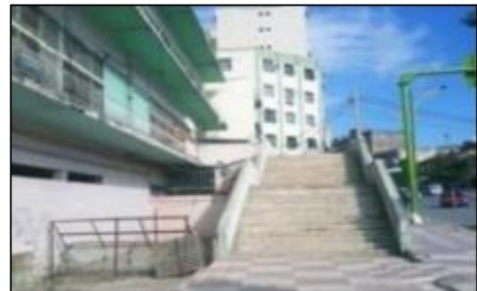
Figure 55: la circulation verticale extérieure dans le bâtiment de l'ancienne gare, source : auteurs
