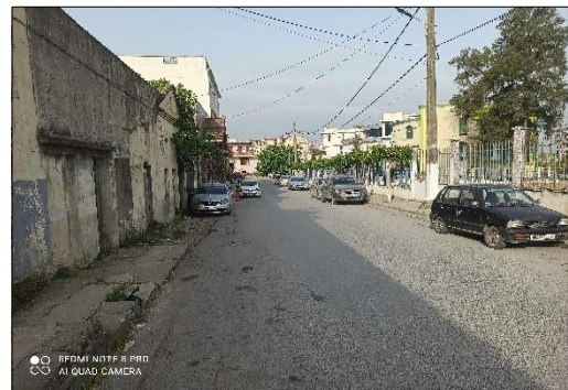
Figure 30: Rue des frères Chafaa, source : auteurs
