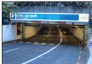
Figure 73: photo du parking d'Aotea source : google image
