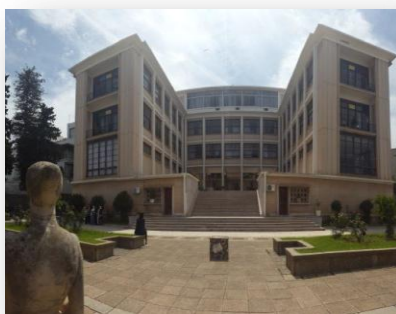
Photo 59 : façade principale d'école supérieure des beaux. Source : Auteurs.
