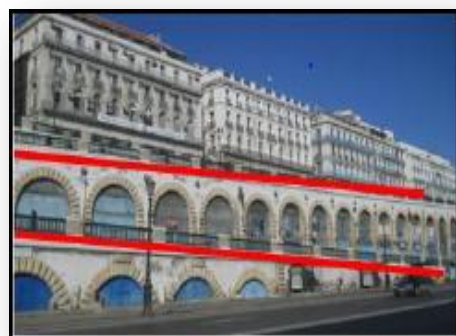
Photo 9 : immeuble Chassériaux « typologie haussmannienne ». Source : Auteurs.
