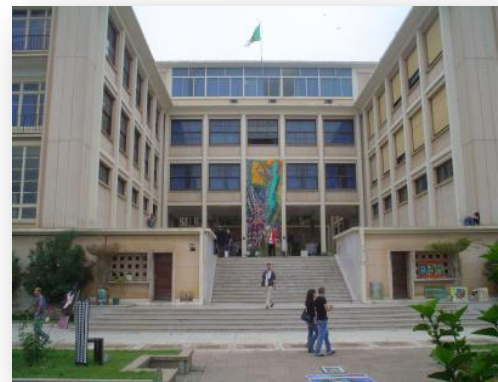
Photo 58 : Ecole supérieure des beaux arts. Source : Auteurs
