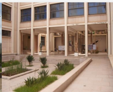
Photo 60 : façade arrière d'école supérieure des beaux arts. Source : Auteurs.
