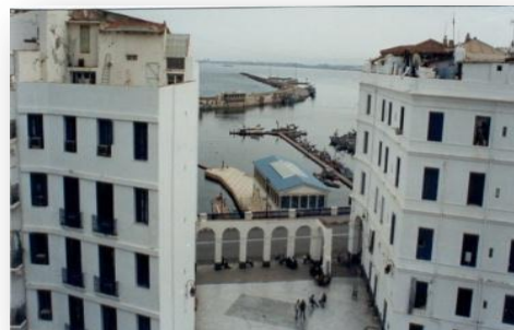
Photo 13 : Place Hadj M'rizak. Source : Auteurs.
