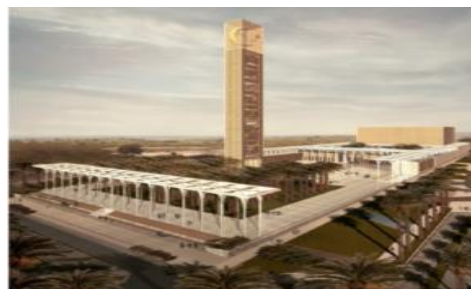
Figure 20: réhabilitation de la grande mosquée d'Alger source : PDAU d'Alger.
