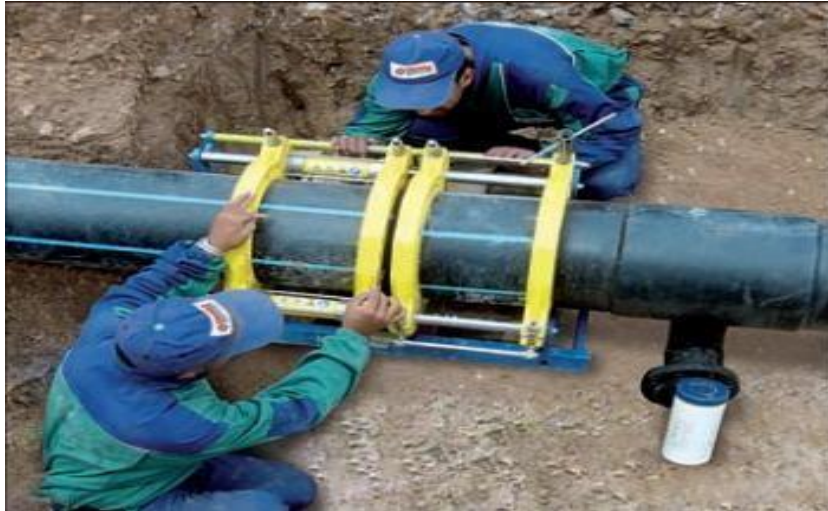
Figure V.4 : électro soudage Bout à bout.
