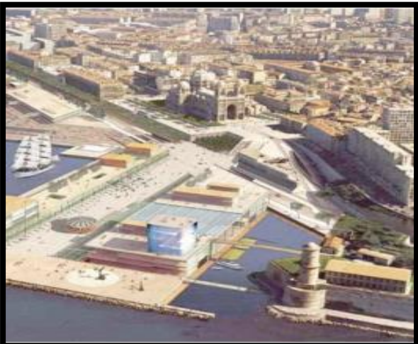
Figure 20 : Après la réalisation de la passerelle Source : Davout, Gueguen, Octobre 1997, P. 73.
