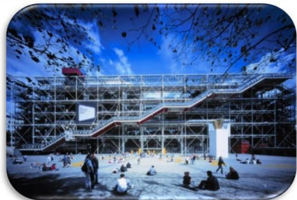
Figure 66 : Façade principale Source : http://www.artscape.fr/wp-content/uploads/2007/11/02.jpg
