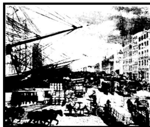
Figure02 : Les abords d'un port industriel Source : Pasquera M A. Luiz J R. 1996, stratégie de développement pour les villes et les ports, Op Cit. P.10.
