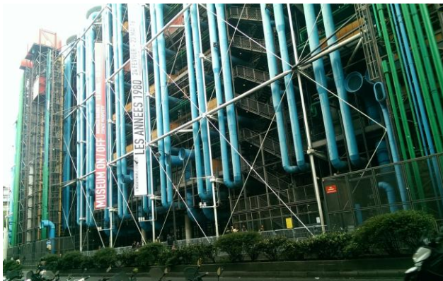
Figure 65 : Façade latérale Source : auteurs
