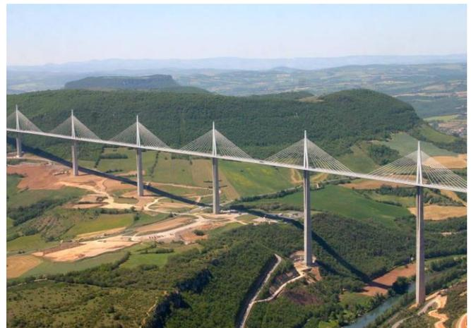
Fig.15. Viaduc de Millau, pont à haubans d'une longueur totale de 2460 m, avec des portées de 204 m et 342 m
