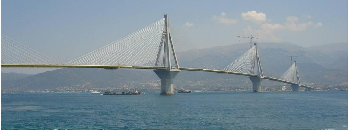
**Fig.16.Pont de Rion-Antirion, mis en service en 2004, d'une longueur totale de 2880 m, avec des portées de 110 m**
