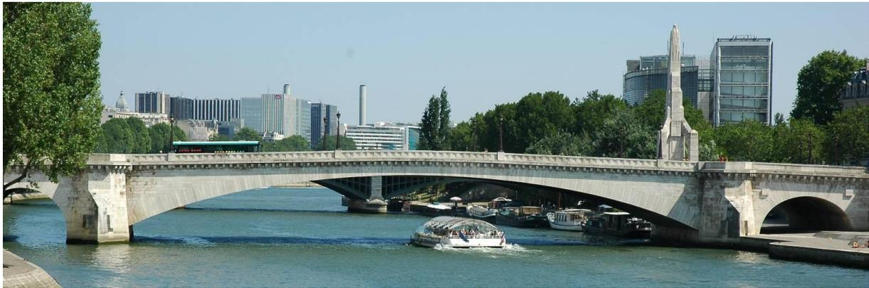
**Fig.10. Pont de la Tournelle (Paris), pont en arc encastré d'une longueur totale de 120 m, début de la construction en 1928 et inauguré en 1930**
