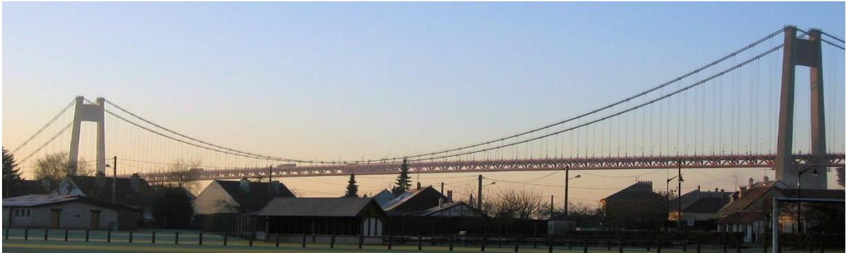
**Fig.7.**Le pont de Tancarville est un pont suspendu qui enjambe la Seine entre Tancarville (Seine-Maritime) et le Marais-Vernier (Eure). Commencé en 1955, il a été mis en service en 1959. Il possédait la plus longue travée centrale d'Europe, 608 mètres.
