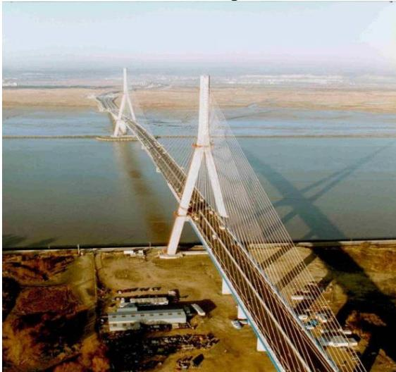
Fig.14. Pont de Normandie, pont à haubans d'une longueur totale de 2141 m, avec une portée centrale de 856 m (1989-1995)
