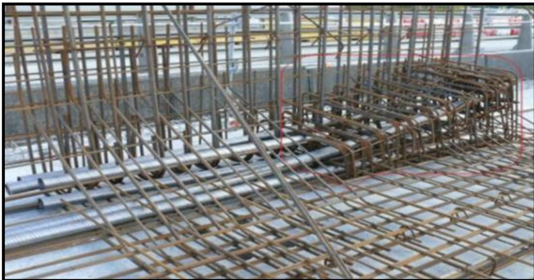
Fig.IX.19 : ferrailage d'un bossage dans un vousoir
