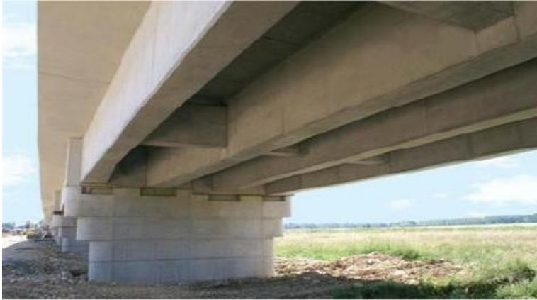
Fig.II.2 : Pont à poutre multiple en béton précontraint
