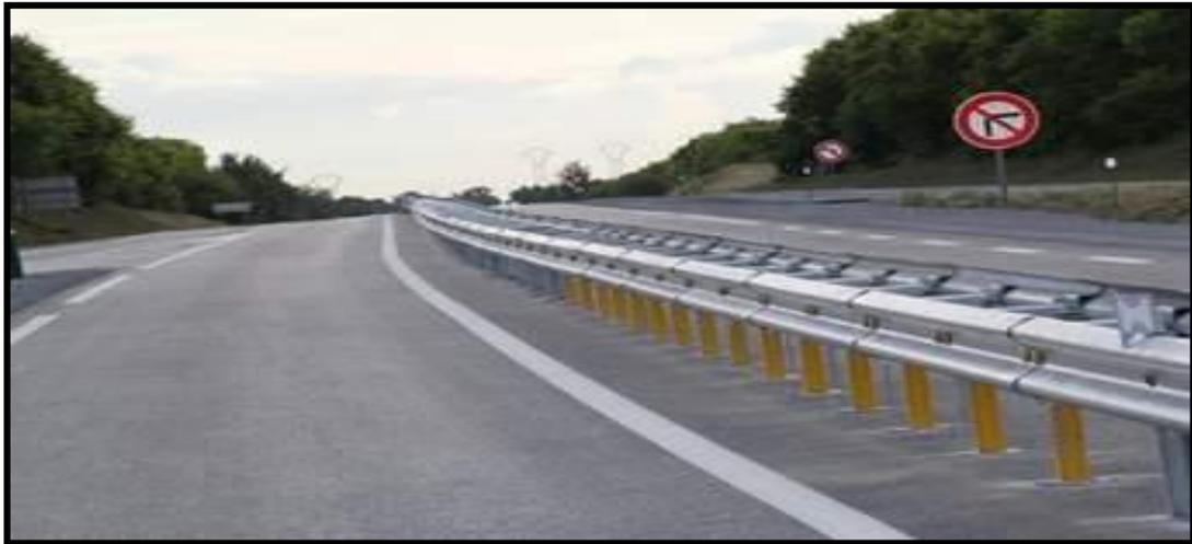
Fig.XI.13 : photo d'une glissière de sécurité
