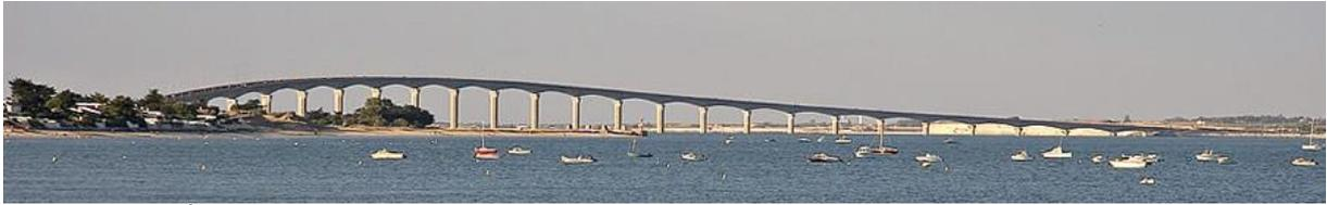
Fig.12. Pont de l'Île de Ré, inauguré en 1988. La longueur totale de l'ouvrage est de 2927 m, avec des portées de 110 m.
