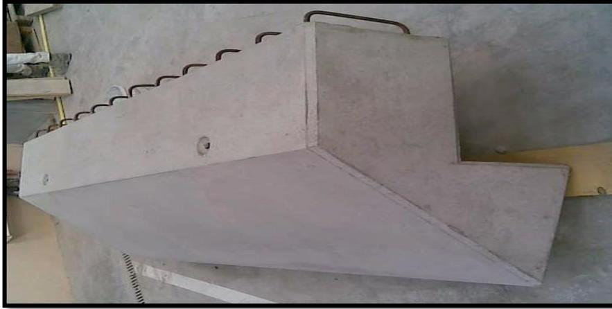
Fig.XI.14 : photo Corniches préfabriquées sur chantier.
