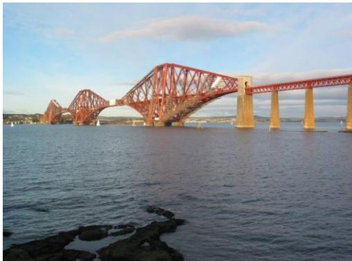
**Fig.5. Pont du Firth of Forth (Écosse), réalisé en 1890, avec deux travées de 521 mètres.**
