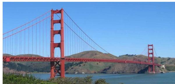
**Fig.9.**Le Golden Gate Bridge à San Francisco (États-Unis), commencé en 1917 et achevé en 1937. Il mesure 1970 m de long, la distance entre les deux tours principales étant de 1 280 m et leur hauteur est de 230 m au-dessus du niveau de l'eau.
