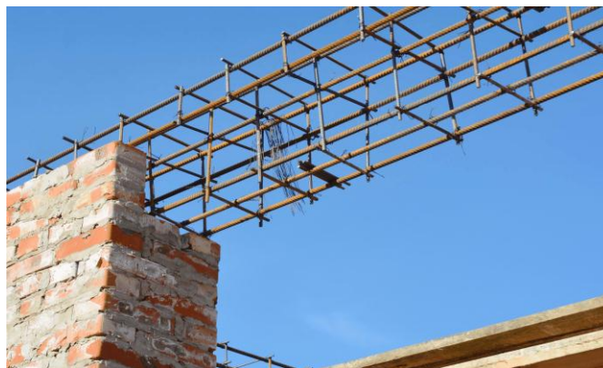
Figure I.14. Confinement par chaînage en béton
