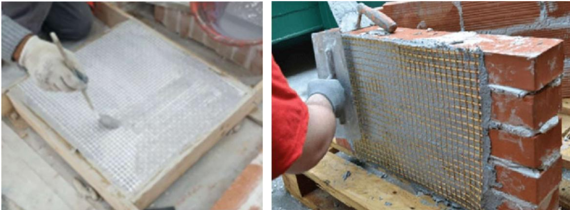
Figure I.18. Confinement par collage externe de PRF et FRCM selon (2)
