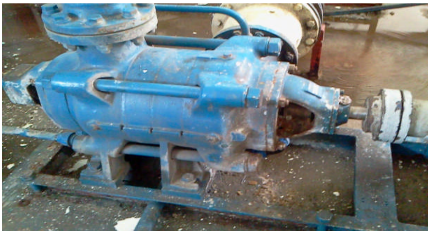
Figure I.4 : Pompe à axe horizontale
