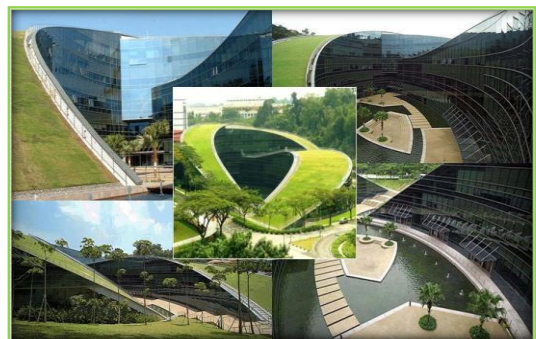
Figure 111: Figure : la terrasse végétalisée afin de récupérer les eaux de pluie. Source : http://ecocopro.com/recuperation-des-eaux-de-pluie-et-toitures-vegetalisees/
