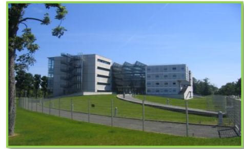
Figure 50 : Ecole d'architecture Marne la vallée.
