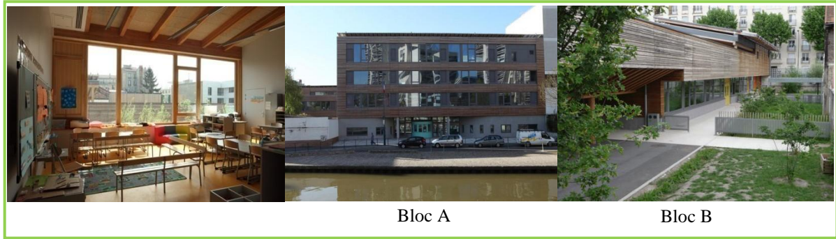
Figure 76 : L'éclairage naturel dans l'école Source. Méandre, atelier d'architecture, urbanisme et environnement - Construction de l'École du Centre « ZERO ENERGIE » et HQE à Pantin, PDF.
