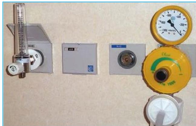
Figure 16 : une installation d'oxygène dans une salle opératoire dentaire
