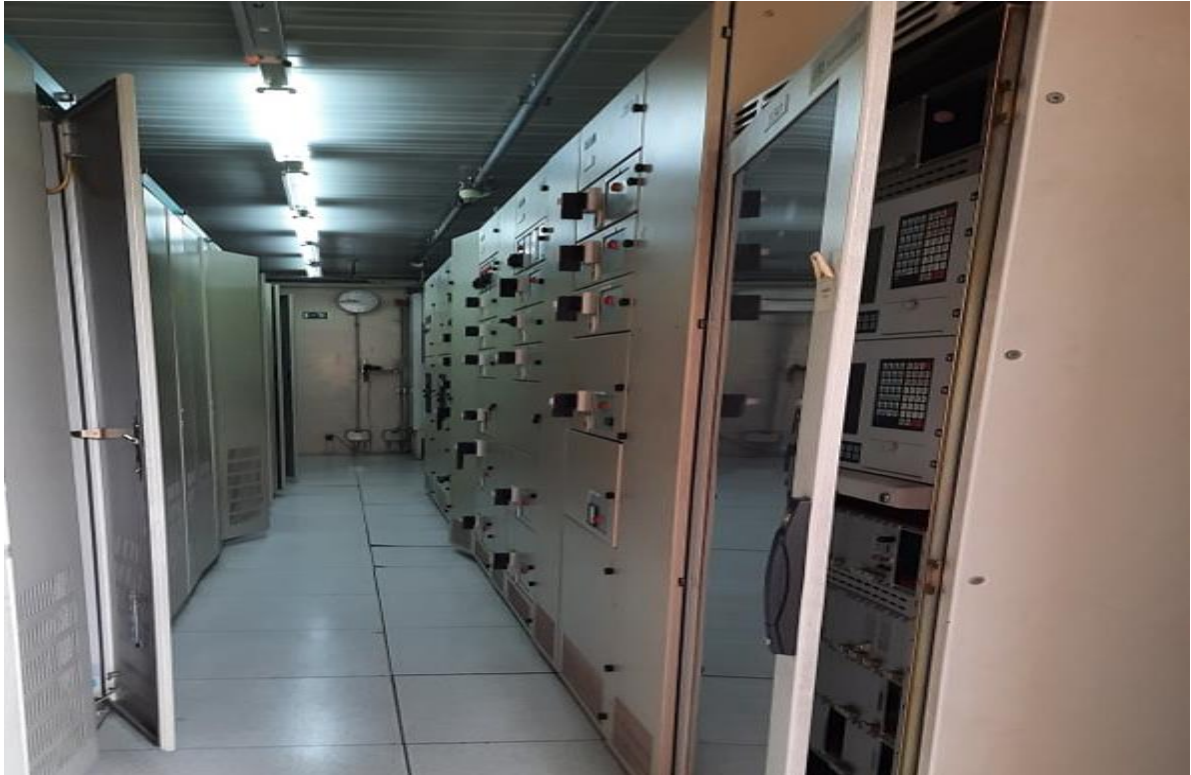
Figure 5: Vue générale du PCC.
