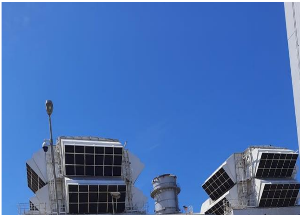
Figure32: vue externe du système d'aspiration d'air et de filtration.
