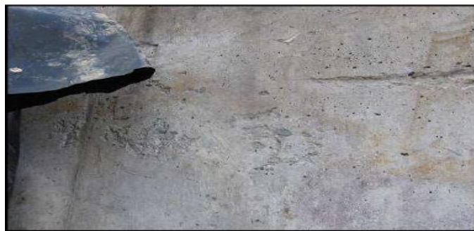
Figure 1.10 : Phénomène de lixiviation des liants [12]
