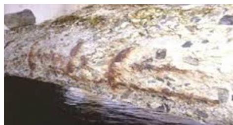
Figure 1.11 : Phénomène de d'Attaques Acides [17]
