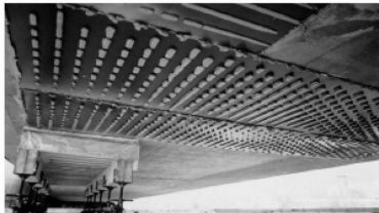
Figure 3.5 Renforcement d'un viaduc par tôles collées
