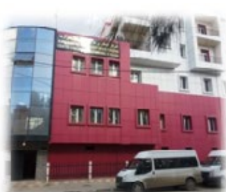
Photo 10. Agence commerciale qui a un gabarit de R+6
