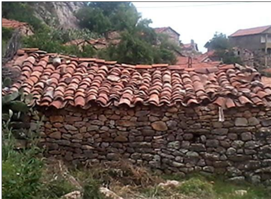
Figure 25. Charpente de maison du village Boumensour ( www.kabylie.com ).
