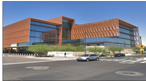
Figure 72. Façade sud du projet (www.archdially.com)
