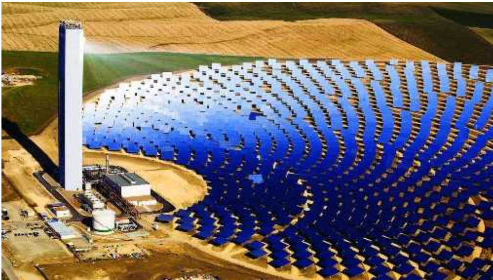
Figure 9 : vue aérienne d'une centrale à concentration et tour
