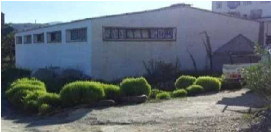
Figure 22 : Vue extérieure de la station d'élevage de Tizirt
