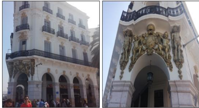
Figure 65 : Façade de l'immeuble Chassériau. Source : Auteurs
