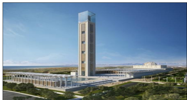
Figure 39 : Grande mosquée d'Alger Source : https://www.google.dz/imghp .
