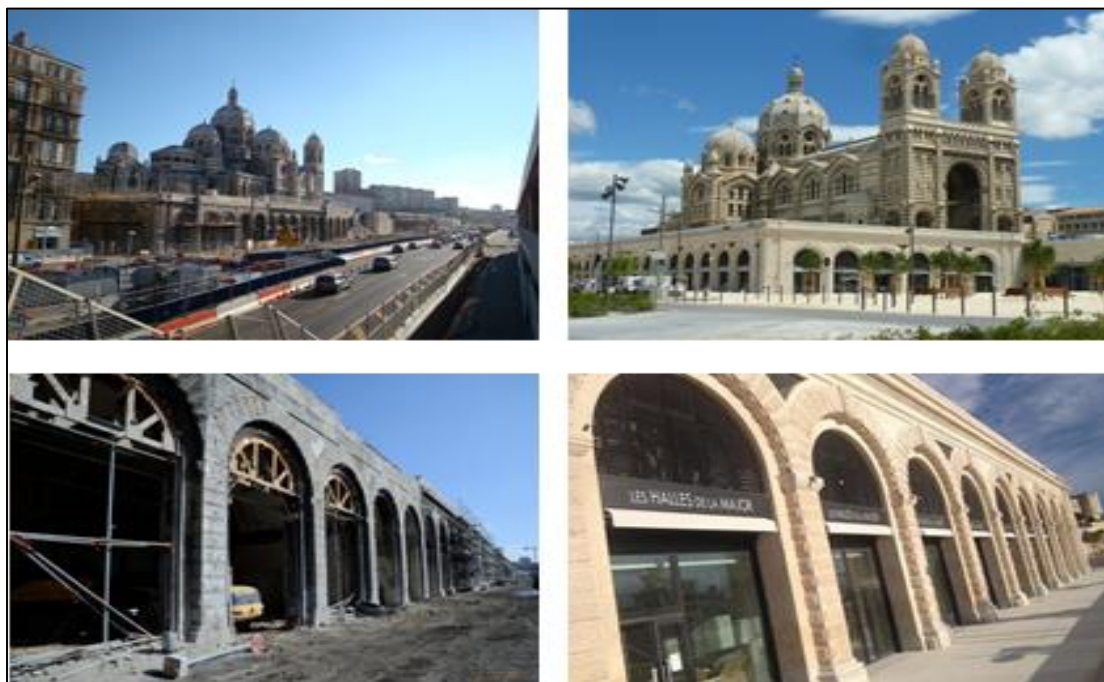
Figure 127 : Les voutes de la major avant et après réhabilitation
