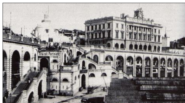
Figure 52 : Vue sur lieu de Bab El Bahr après aménagement des escaliers de la pêche. Source : https://www.google.dz/imaghp .
