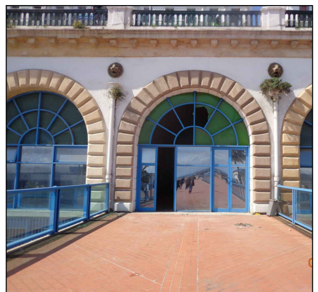
3. Passerelle menant des voûtes vers la mer
