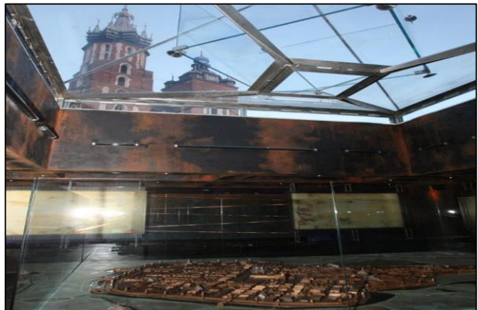
Figure 119 : Vue sur la lucarne en verre Source : Archirama.muratorplus.pl
