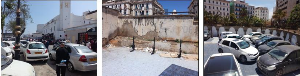
Figure 71 : Etat du bâti
