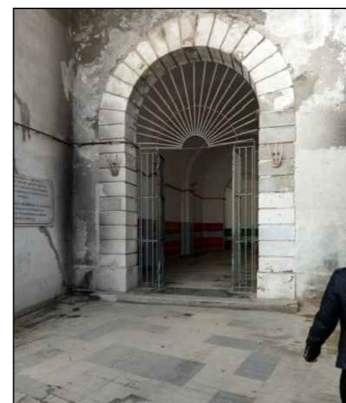
5. Accès vers les voûtes de la pêcheurie
