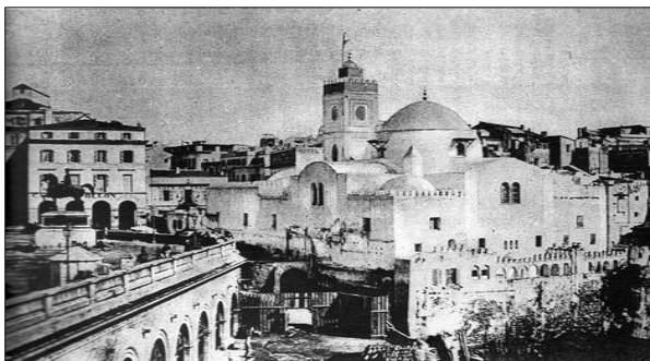
Figure 51 : Photo à partir du Boulevard de l'impératrice après aménagement Source : https://www.google.dz/imaghp .
