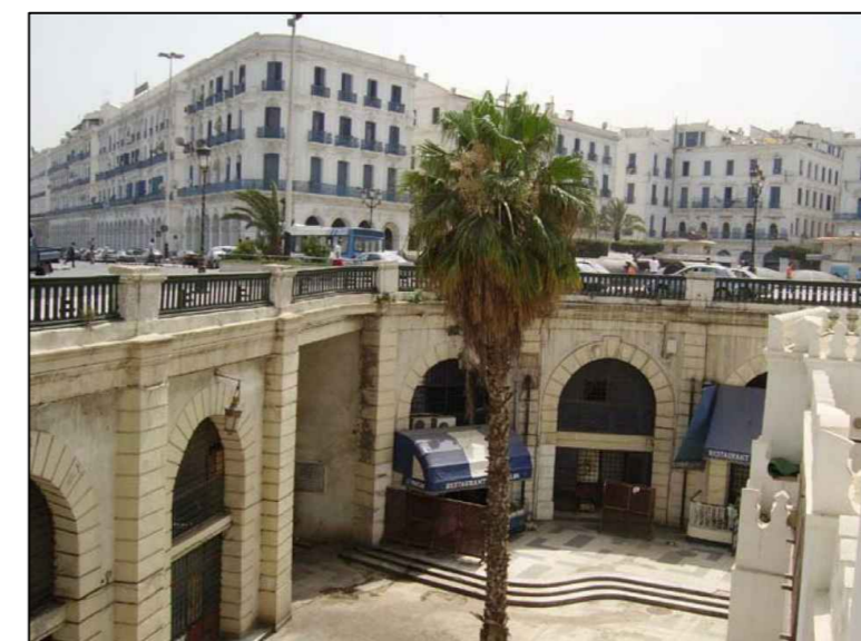
6. Accès vers les voûtes de la place des martyrs mal matérialisé
