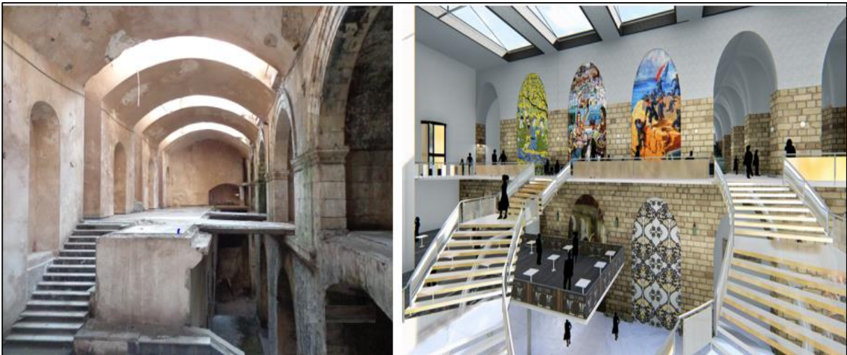
Figure 132 : Avant et après intervention sur le hall d'entrée.
