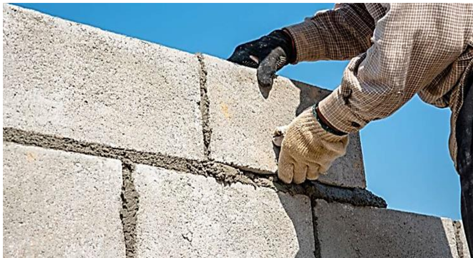
Figure I.12: Pose de mortier de hourdage [11].
