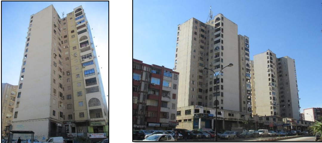
Figure 62 : Résidence EPLF, à droite T1, à gauche T2 & T3. (Source : auteur, 2014)
