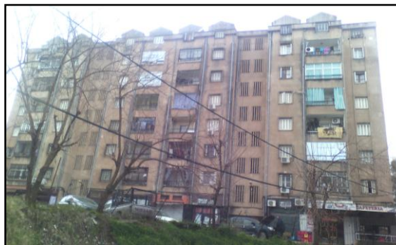
Figure 5 : Difficulté d'indentification de l'aspect de la façade, dissimulé par le marquage fonctionnel. Tizi-Ouzou. (Source : auteur)
