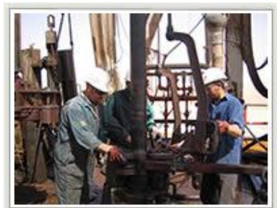
Figure I.4: L'appareil de forage.
