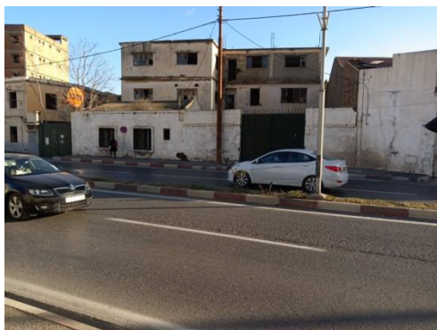
Figure 31 : Photo d'une habitation abandonnée Source : Auteurs
