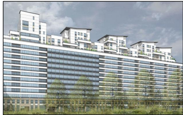
Figure 57 : Barre Balmont à Lyon Source : lemoniteur.com
