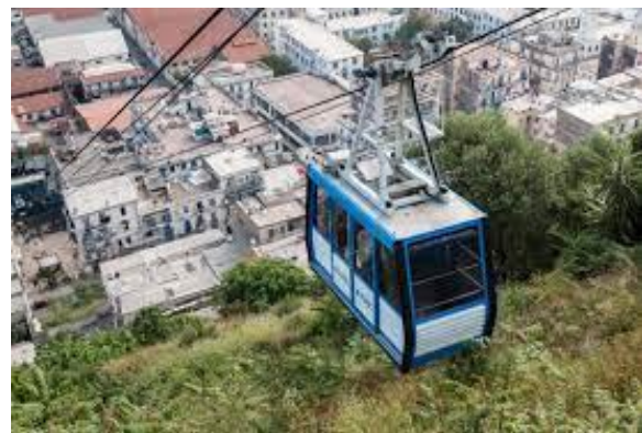
Figure 20 : Image du téléphérique d'Alger
