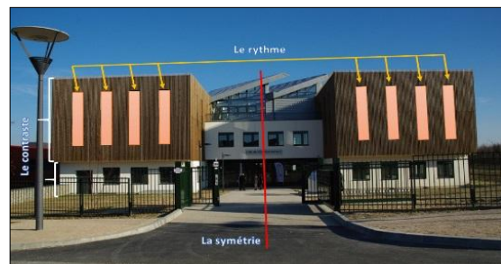
Figure 76 : Concepts sur la façade principale de la cité Source Google Maps - Auteurs
