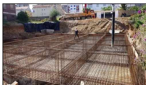
Figure 126 : Ferrailage du radier général Source : www.imobboussaba.fr
