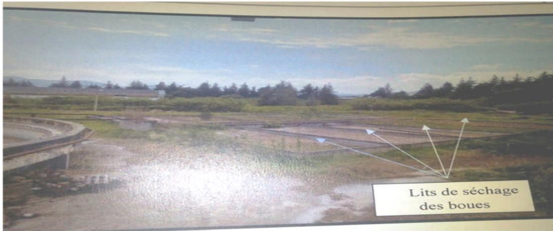
Fig 20 : Stockage des boues dans les lits de séchage
