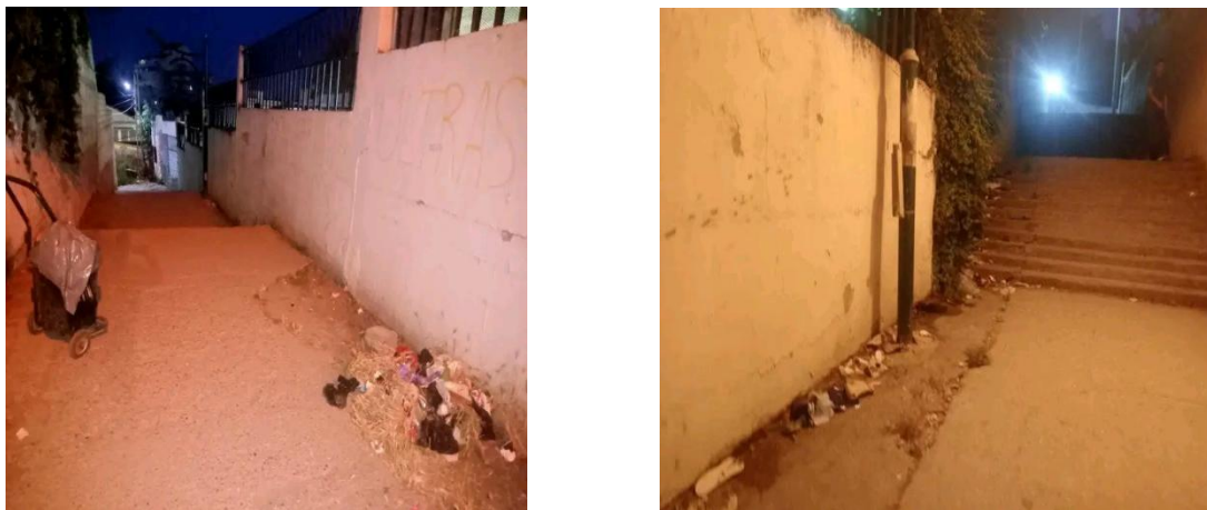
Photo prise au niveau des escaliers de CHU.
