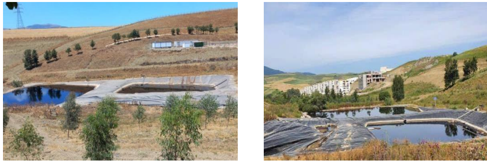
Figure 20 : Station de traitement de lixiviats avant l’extension de casier (original).
