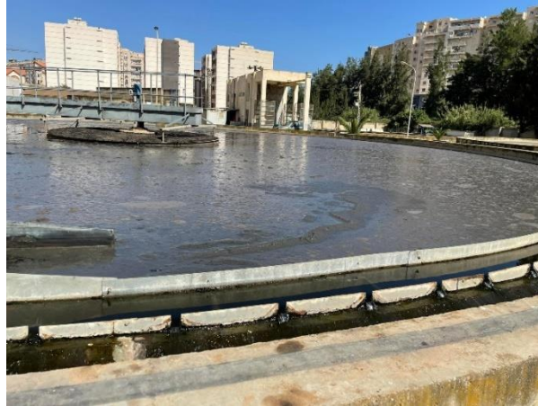
Figure 31 : Bassin Clarificateur.
