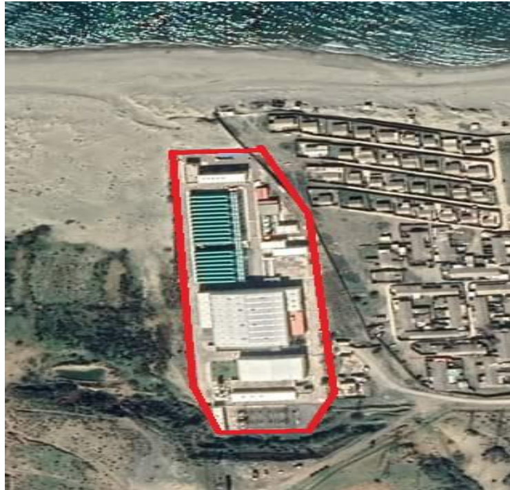
Figure 72 : Image satellitaire de la station de cap Djinet (trait en rouge : limite de la station).
