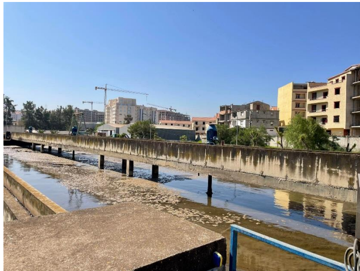
Figure 30 : Bassin d'aération.
