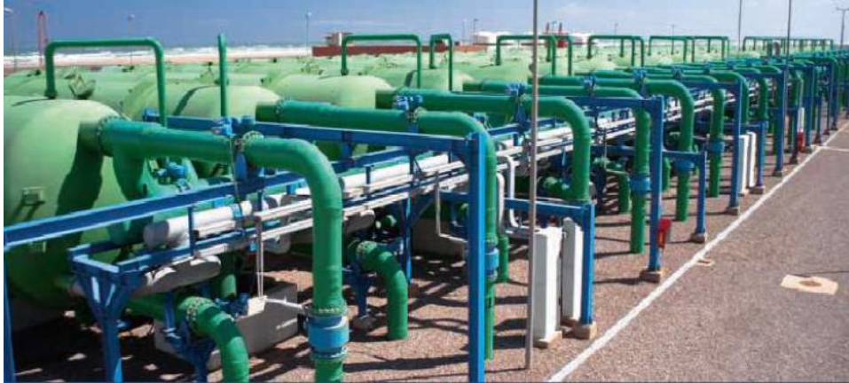
Figure 76: Filtres à sable et anthracite.
