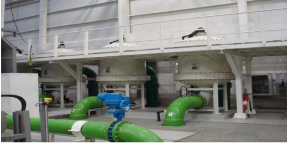
Figure 77: Filtres à cartouches.
