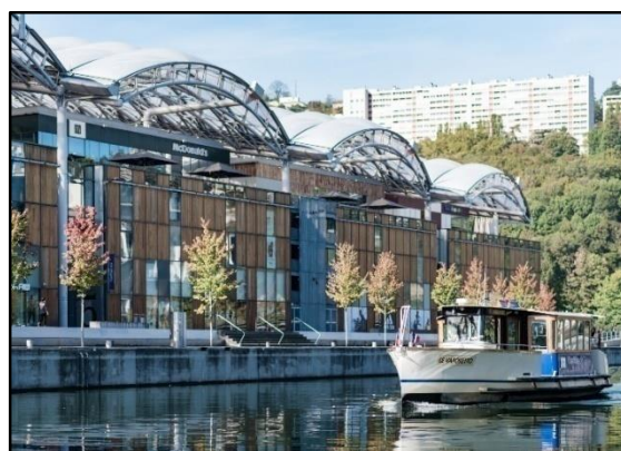
Figure140: La toiture en ETFE du centre commercial et de loisir de Confluence de Lyon. Source : Google
