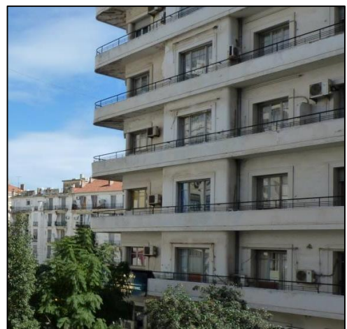
Figure 59 : immeuble. Source : auteur
