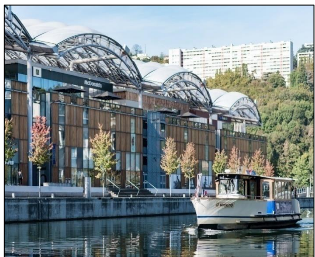
Figure 117 : Vue sur le Centre commercial et de loisir de Confluence de Lyon. [En ligne].Source: https://www.google.com
