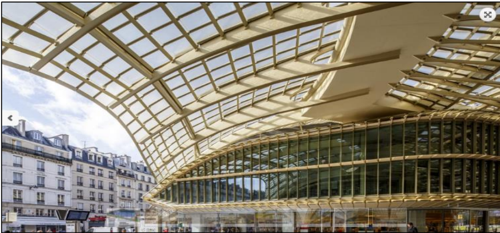
Figure104 : Façade du projet. Source : Google
