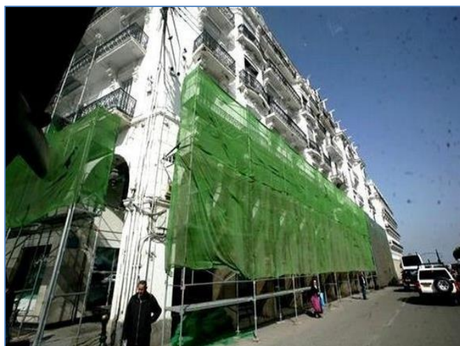
Figure 85 : La réhabilitation des balcons Haussmannien
