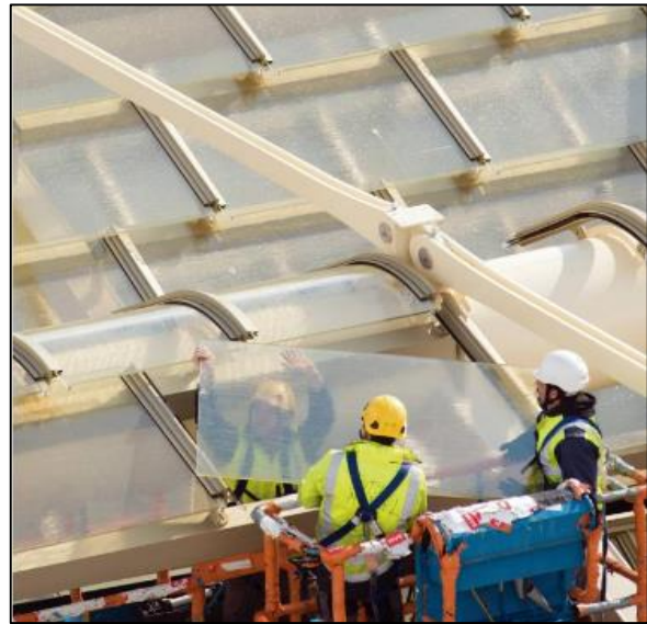
Figure 102 : La méthode de pose du verre
