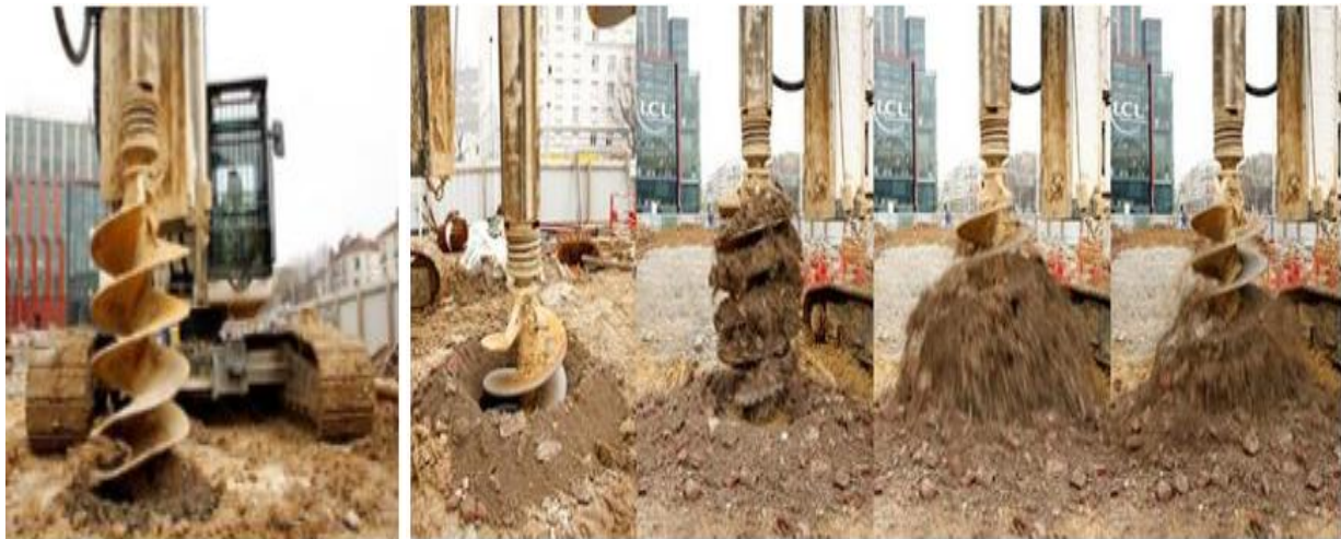
Figure I.19. Illustration d'une foreuse- foré simple
