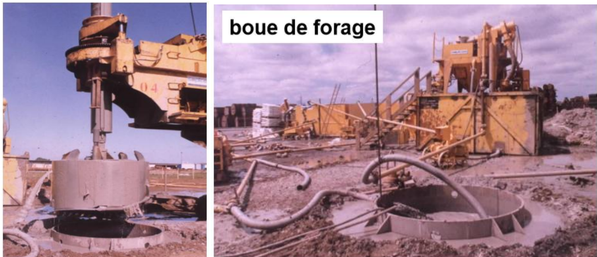
Figure I.21. Outils de forage à la boue
