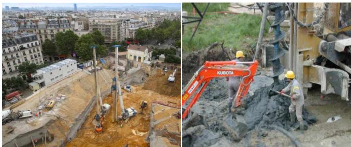
Figure I.23. Outils de forage à tarière creuse
