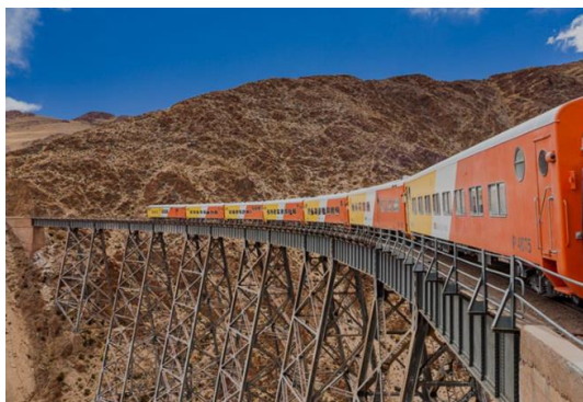
Figure I.7. Viaduc de Salta, Argentine [7]
