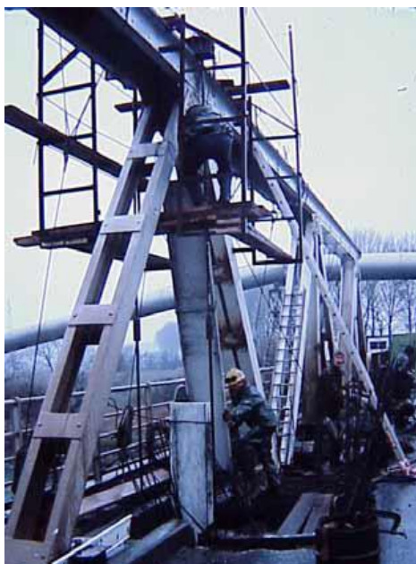
Figure III.9. Remplacement d'un montant d'une poutre treillis [17]
