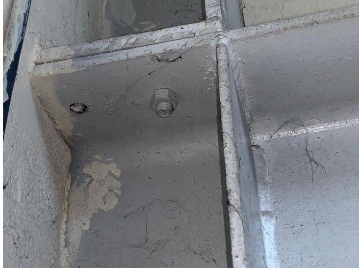
Figure IV.17. Cisaillement des boulons.
