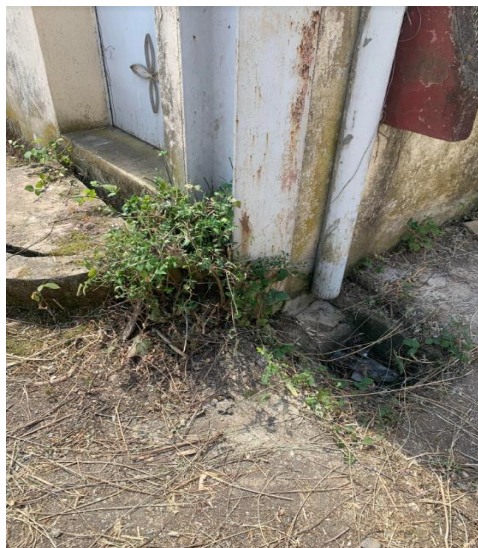
Figure IV.8.a. Évacuation des eaux sur le pied de poteau
