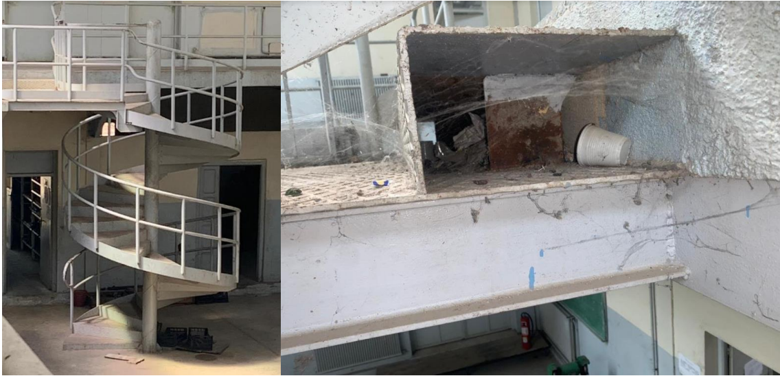
Figure IV.11. Présence des pièges à poussières
