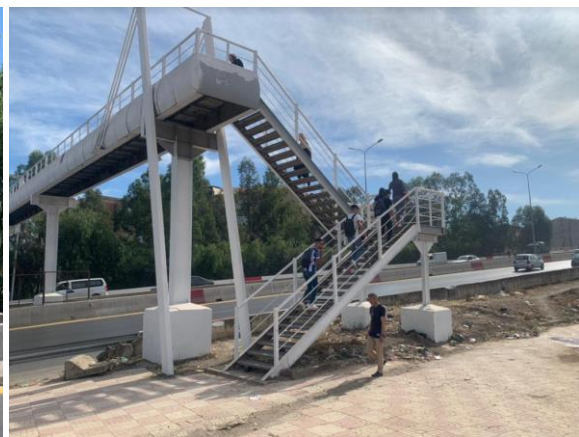
Figure IV.3.b. le côté menant à la gare
