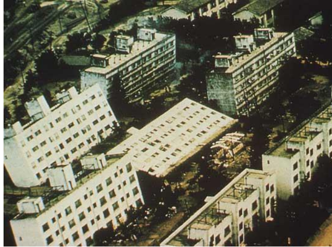
Figure II.19. La liquéfaction du sol entraîne le renversement des bâtiments [13]
