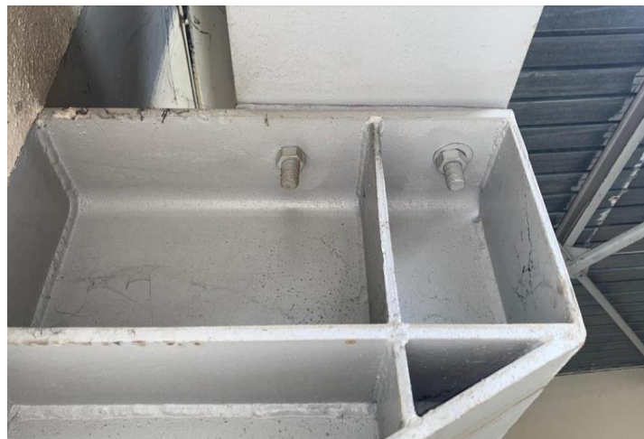
Figure IV.16. Absence de rondelle de boulon dans certains cas.
