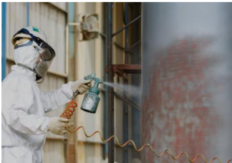
Figure III.12. Application d'une peinture anti corrosion [32]
