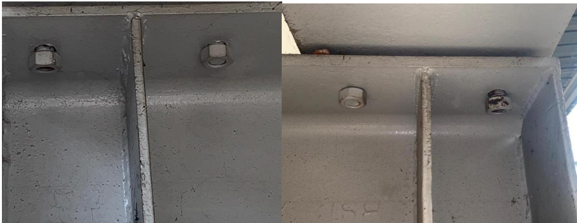
Figure IV.15. Dessérage des boulons
