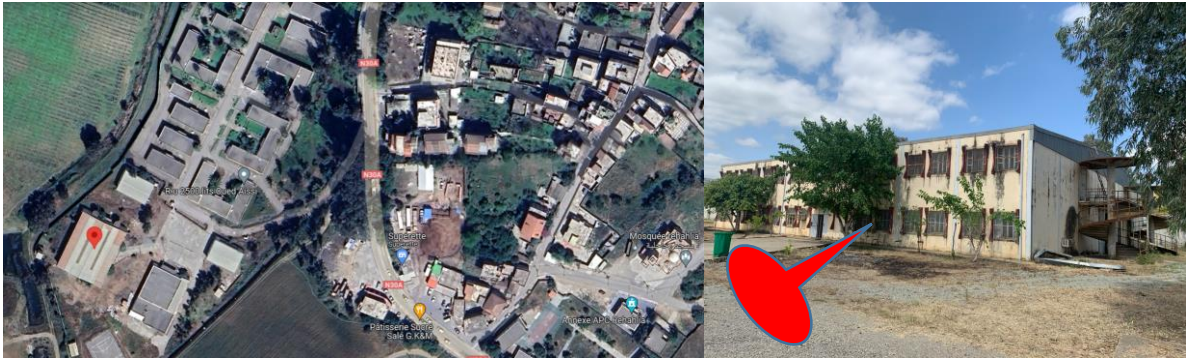
Figure IV.7. Le hall métallique du campus universitaire Oued Aissi
