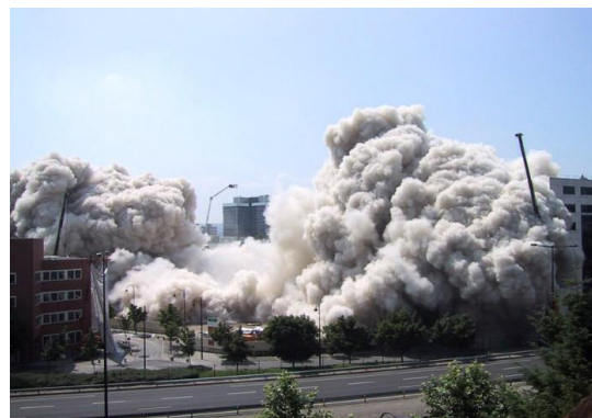
Figure II.9. Explosion d'un immeuble [13]
