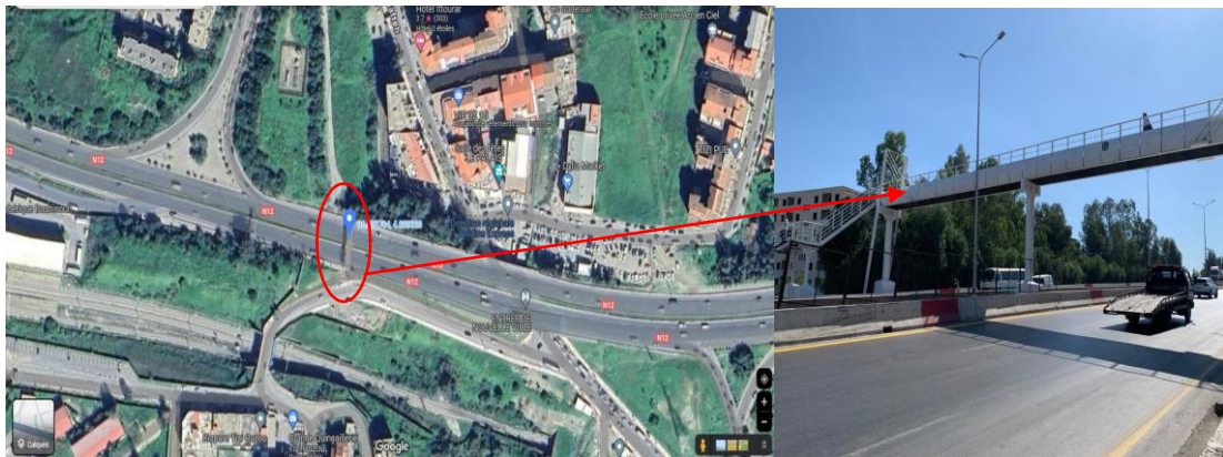
Figure IV.1. La passerelle reliant la station de bus à la nouvelle ville de T.O.
