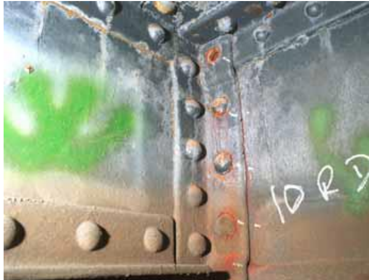
Figure III.11. Rivet défectueux [17]
