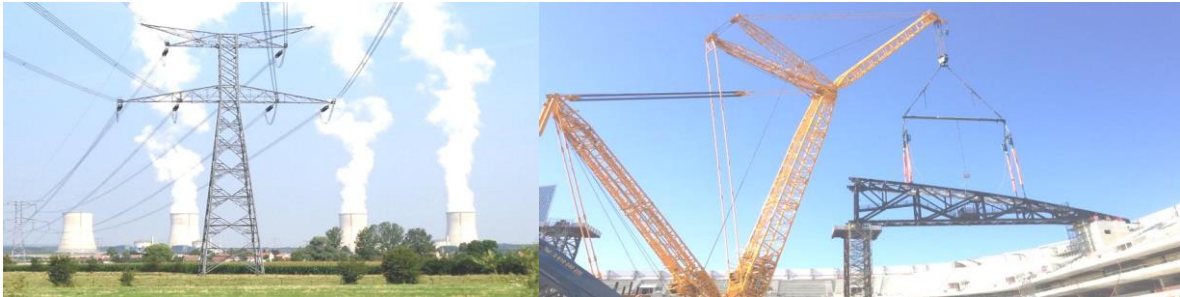
Figure I.9. Pylône de ligne électrique [2]
