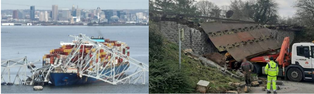
Figure II.10. Un pont aux États-Unis s'effondre après avoir été heurté par un bateau [20]
