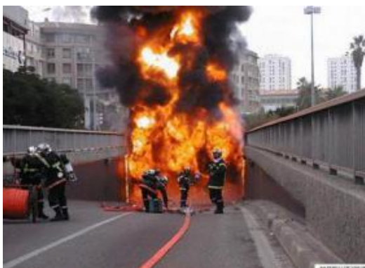
Figure II.8. Incendie dans un tunnel [13]
